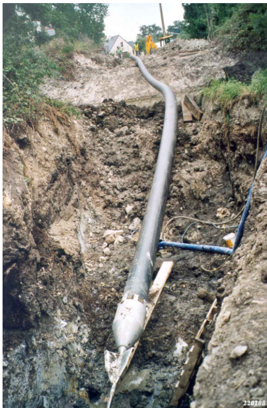
Bild links: Das PE-Rohr AD 315 mm, 120 m lang, die Mini-Splithülse AD 368 mm und das Splittgestänge 12" mit 3 Schneiden kurz vor dem Einzug.
