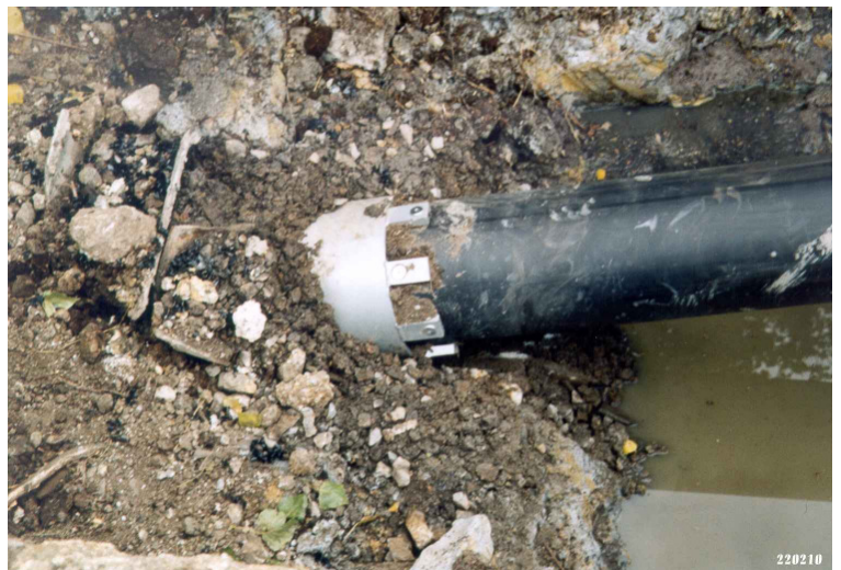
Bild links: Das PE-Rohr AD 315 mm, 120 m lang, die Mini-Splithülse AD 368 mm und das Splittgestänge 12" mit 3 Schneiden kurz vor dem Einzug.
