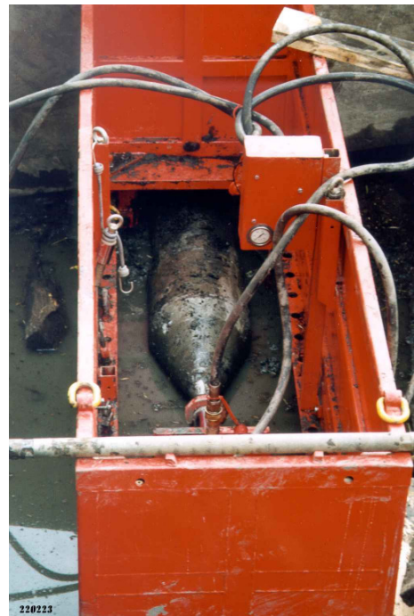
Bild links: Das PE-Rohr ist angekommen. Der Hauptzylinder wird im TERRA-HYDROCRACK nach hinten geschoben. Jetzt können Splittgestänge, Aufweitkopf und PE-Rohr einfach in den HYDROCRACK gezogen werden.
