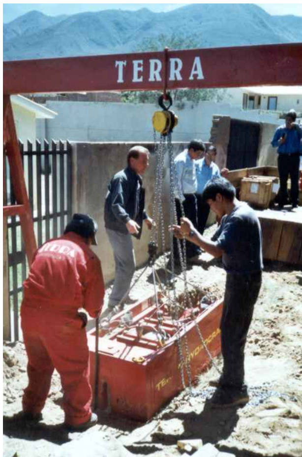
Bild oben links: Der TERRA-HYDROCRACK/ Kurzversion wird in die Grube abgelassen.
