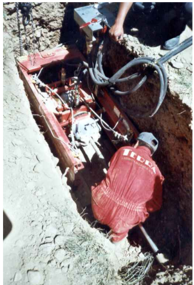
Bild oben rechts: Die Gestänge werden in 1.5 Stunden in das 100 m lange Altrrohr eingeschoben.
