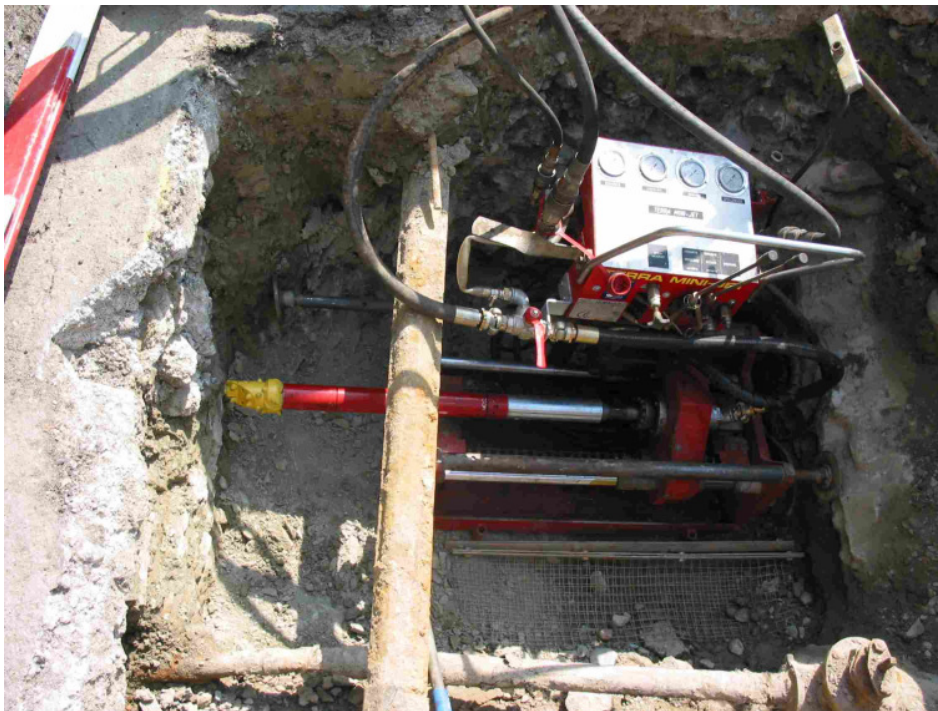
Oben: Der TERRA MINI-JET mit dem TERRA-ROCK Druckluft-Schlagkopf \varnothing 65 mm. Zum Starten wird der kurze Startadapter anstelle des Sondengehäuses verwendet.
