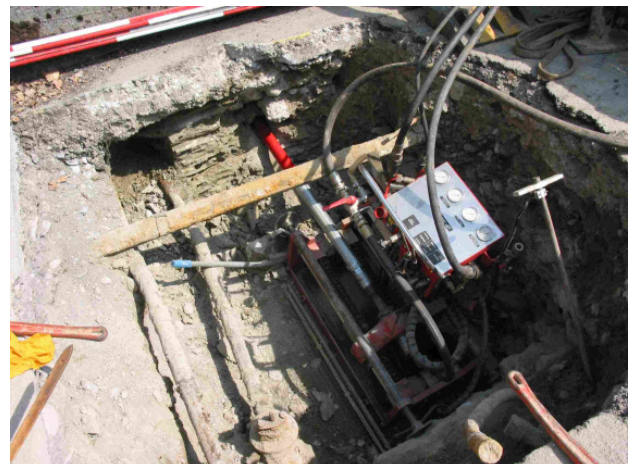
Rechts: Der TERRA-ROCK Druckluft-Schlagkopf \varnothing 65 mm beim Einlaufen, jetzt mit Sondengehäuse.
