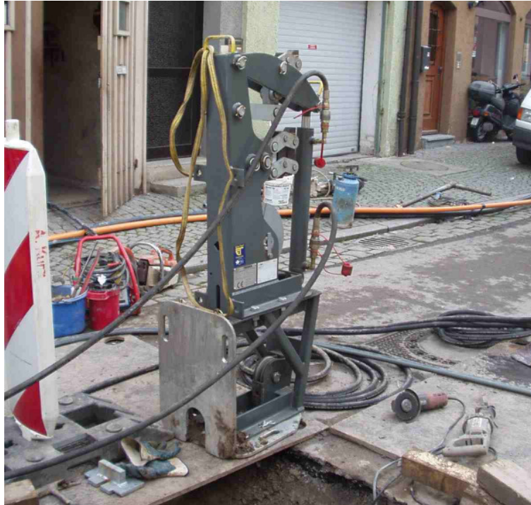
Der TERRA-EXTRACTOR X 100 wird für das Absetzen in die Grube vorbereitet.
