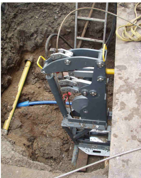
Der TERRA-EXTRACTOR X 100 wird in der Grube positioniert. Das Zugseil wird durch das Altrohr geschoben.
