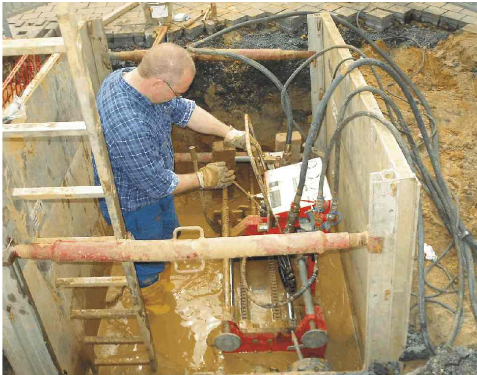
Der TERRA MINI-JET in seiner verbauten Startgrube während der Pilotbohrung.
