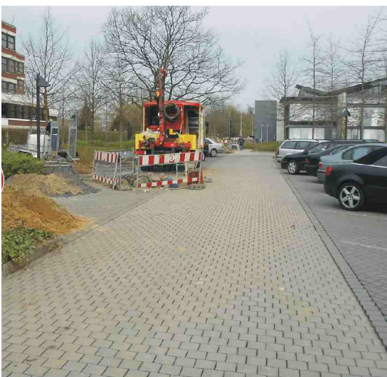
Der Blick zur Startgrube zeigt den Verbundsteinweg, unter welchem die HDPE-Rohre DA 225 mm zu verlegen sind.
