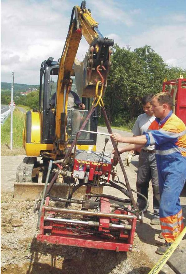
Der TERRA MINI-JET wird mit einem Mini-Bagger in die Startgrube abgelassen.
