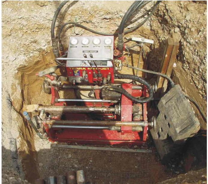
Der TERRA MINI-JET ist in der Grube ausgerichtet und bereit für die Pilotbohrung.
