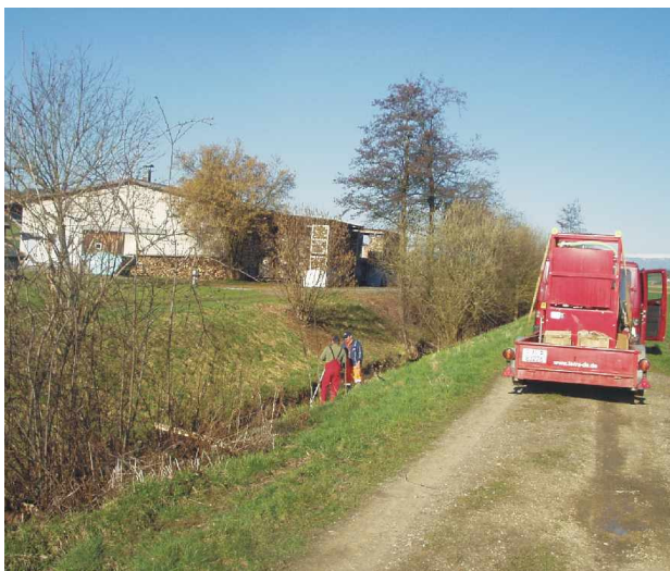
Der Blick zeigt die Anforderung an die Bohrung, die rechts vom Anhänger aus der Startgrube nach links unter dem Bach bis zur linken hinteren Hausecke verläuft.
