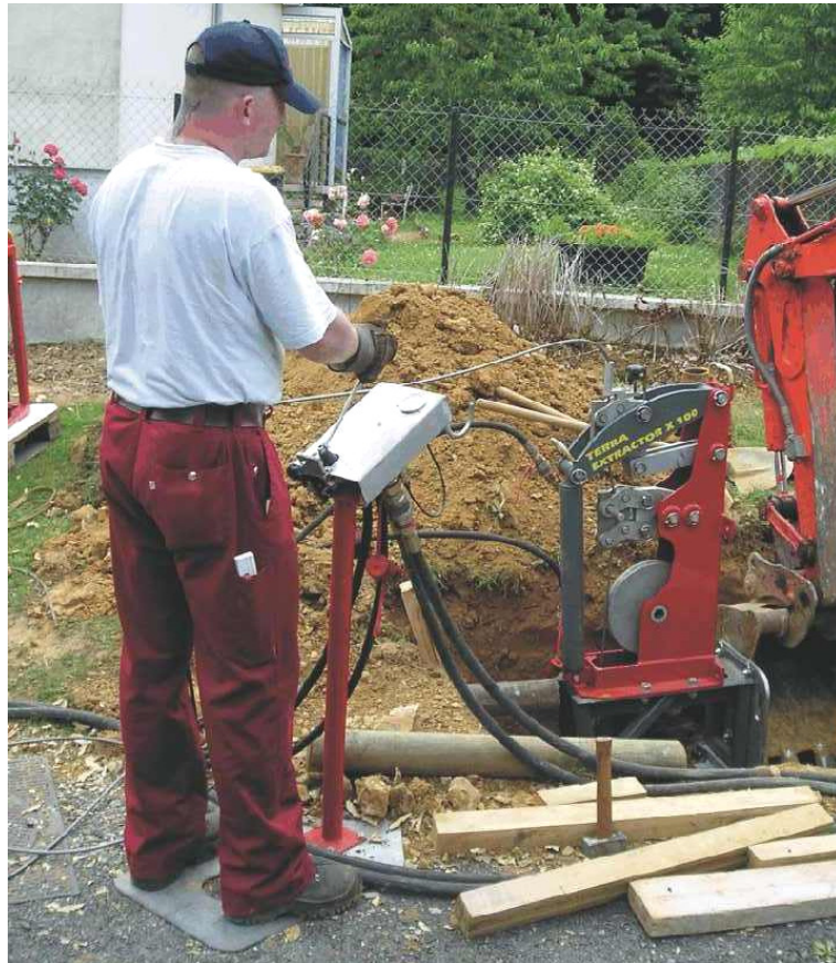
Der TERRA-EXTRACTOR X 100 in seiner Startgrube. Der Bedienungsmann steht neben der Grube und steuert mittels Bedienpult die Anlage.
