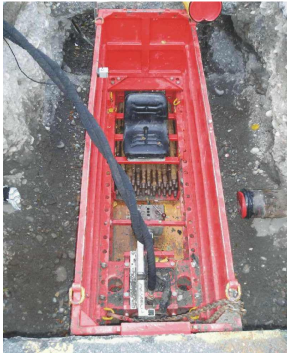
Der TERRA-HYDROCRACK HC 600 C+ ist in der Startgrube positioniert. Gut zu sehen die gefüllte Gestängebox unter dem Arbeitssitz.
