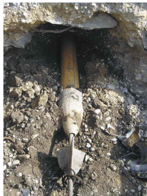
Das dreischneidige Splittmesser sowie das neue HDPE-Rohr DA 250 mm erreichen die Zwischengrube.
