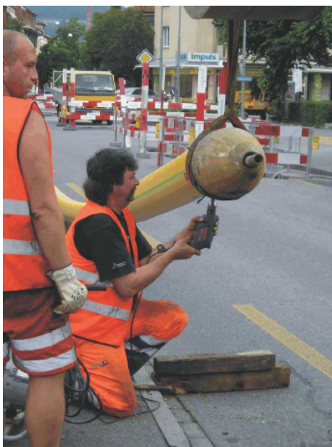
Das neue HDPE-Rohr DA 250 mm wird mit dem Aufweitkonus Ø 325 mm eingezogen.
