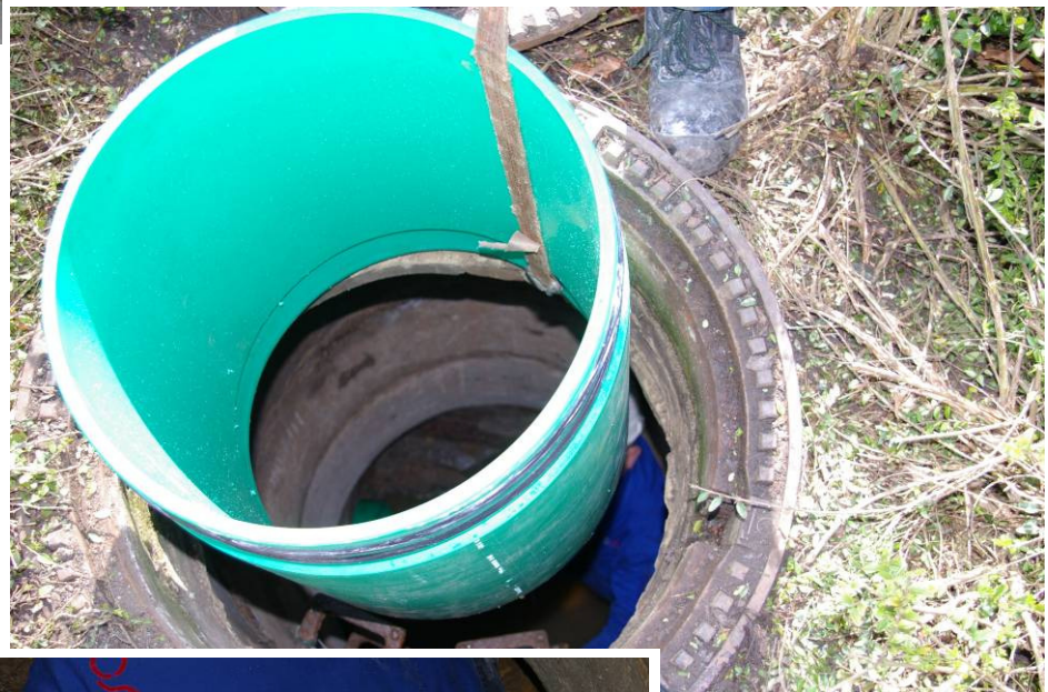
→ Herablassen des nächsten Rohrmoduls PP-HM DA 485 mm durch Schachtöffnung.
