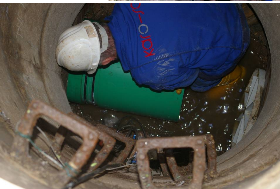
← Einbau des Rohrmoduls war ohne Wasserhaltung möglich.
