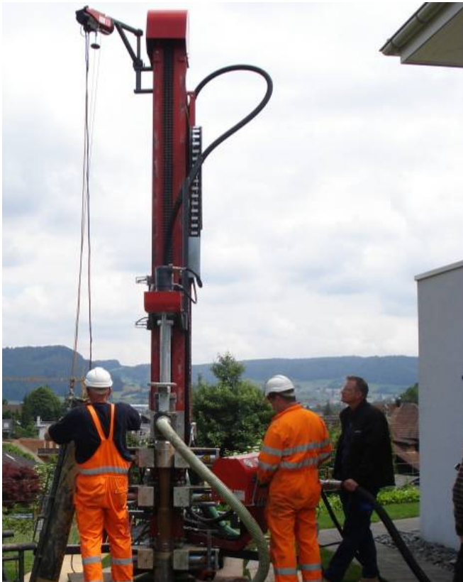
Die zweite Bohrung wird abgeteuft
