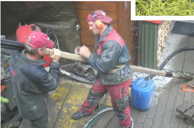
↓ Die Erdsonde 4x DA 40 mit 25 mm Füllrohr wird vorbereitet und abgesenkt. ↑
