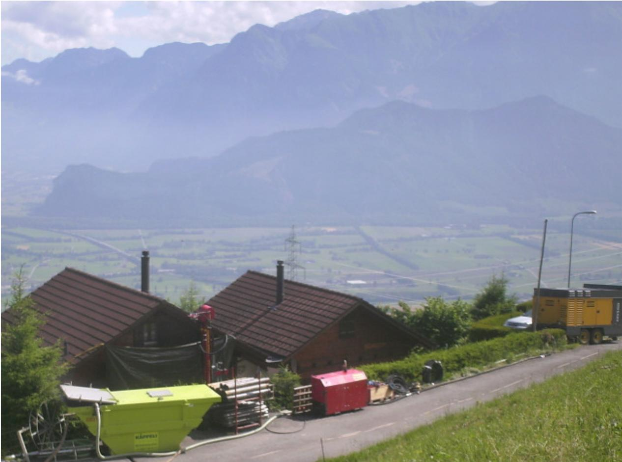
Trotz der engen Platzverhältnisse werden alle Komponenten entlang der Strasse installiert. Rechts der Kompressor, in der Mitte das TERRA-Antriebsaggregat und die Bohrgestänge, links die gedeckte Schlammmulde.
