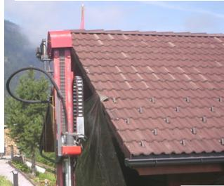
Der Bajonettverschluss wird ausgeklinkt, der 5" Imlochhammer mit der 150 mm Bohrkronne bohrt alleine weiter.
