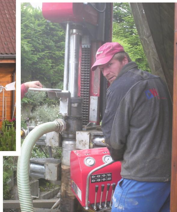
Die Bohrarbeiten können beginnen. Die 125 m tiefe Bohrung wird durch den harten Fels mit einer Bohrgeschwindigkeit von 12-18 m pro Stunde abgeteuft.
