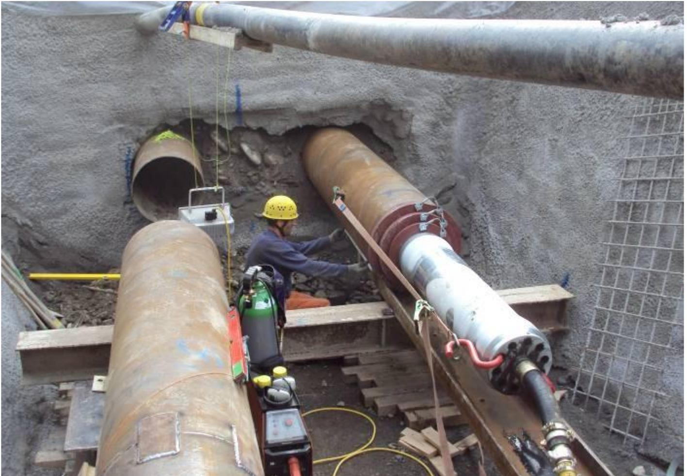
In Wimmis, welches im Berner Oberland liegt, mussten zwei Stahlrohre mit  $\varnothing$  600 mm über eine Länge von 17 m unter der eingleisigen Eisenbahnstrecke verlegt werden. In die verlegten Stahlrohre wurden anschliessend Produktrohre für Fernwärme eingelegt. Die in Adelboden und Oey ansässige Bauunternehmung Burn & Künzi entschied sich, für dieses Bauvorhaben den neu erworbenen TERRA-HAMMER TR 360 einzusetzen.
