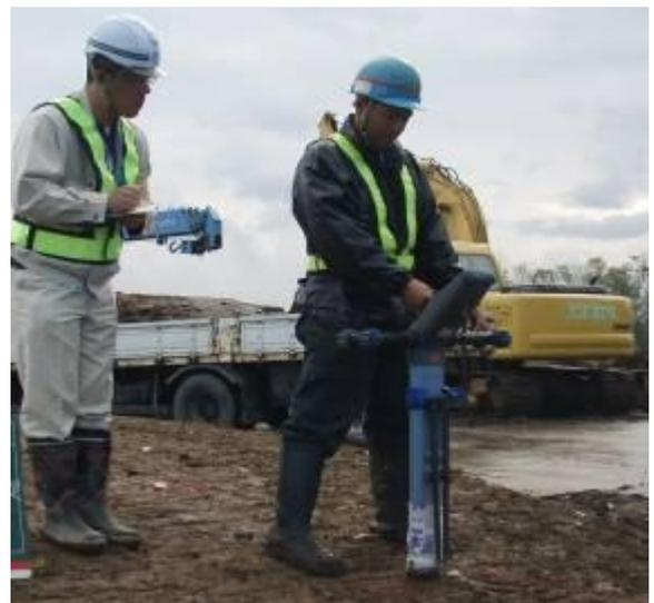
Die Pilotbohrung wird geortet und dokumentiert.
