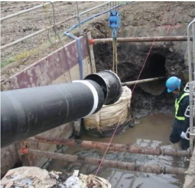
Der Bohrkanal ist auf  $\varnothing$  800 mm aufgeweitet. Jetzt kann das HDPE-Rohr DA 560 mm eingezogen werden.
