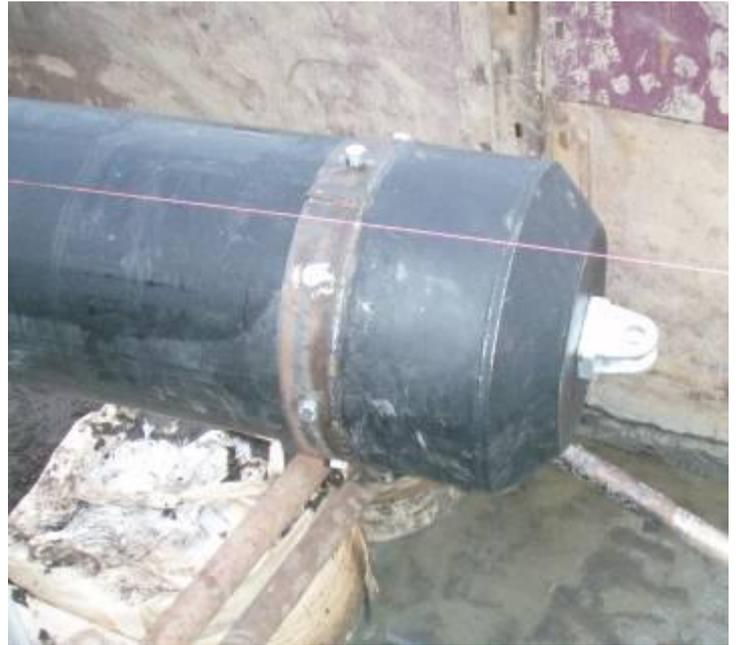
Der Spreizdorn wird auf das HDPE-Rohr 560 mm montiert.
