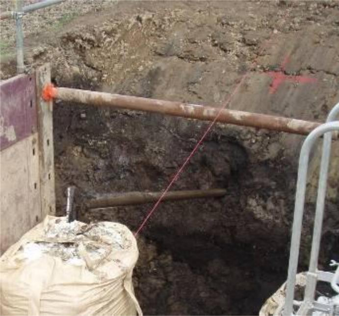
Der Bohrkopf erreicht zielgenau die Zielgrube.
