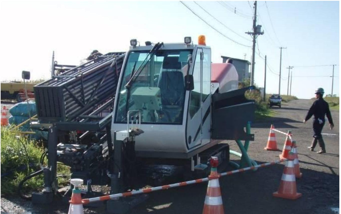
Das Tiefbauunternehmen Iwashita Sangyo aus Hachiken Nishi-Ku, Japan hat mit seiner steuerbaren HDD-Bohranlage TERRA-JET 8522 S ein HDPE-Rohr DA 560 mm verlegt. Die Länge betrug 60 m. Der Untergrund war gut bohrbarer Lehm.
