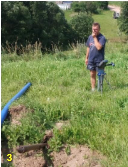
Der Bohrkopf erreicht den Zielpunkt exakt in der Verlängerung der neuen Wasserleitung.
