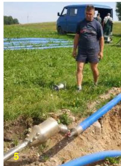
Der Aufweitkopf DA 260 mm mit angehängtem 130 m langem HDPE-Rohr DA 110 mm.
