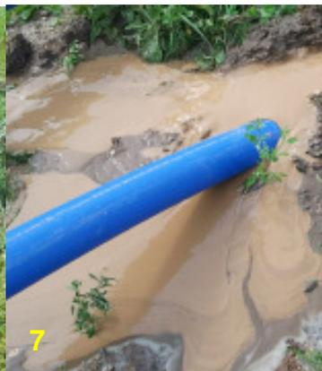
Das HDPE-Rohr wird eingezogen. Der Bohrschlamm fließt kontinuierlich aus dem Bohrkanal.
