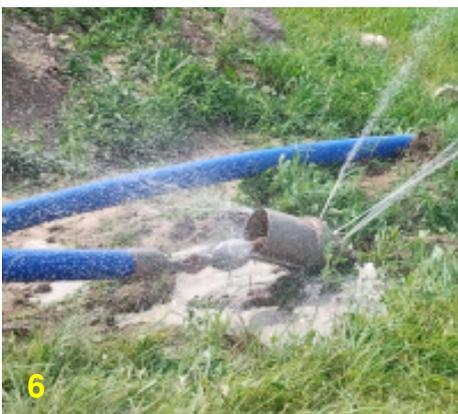
Die Aufweitung beginnt. Das Bentonit spritzt aus den Düsen des Aufweitkopfs.
