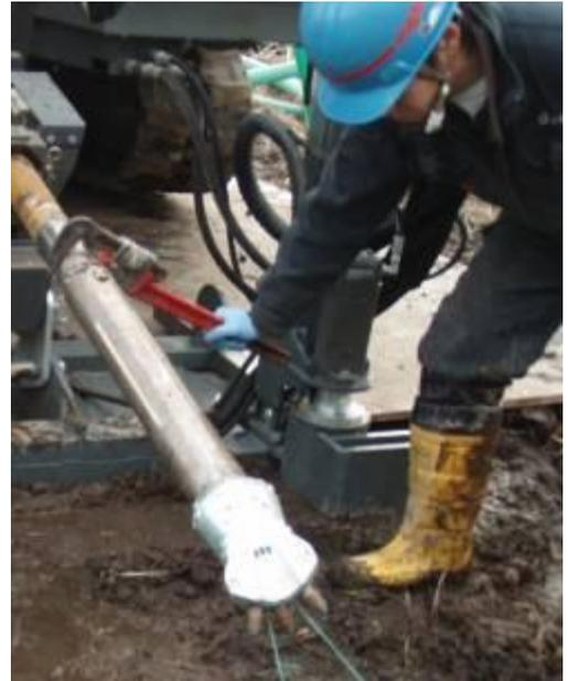
Der Drei-Fingerkopf ist montiert, da die Pilotbohrung durch harten Untergrund verläuft.
