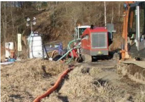
Der TERRA-JET 8522 S während der Pilotbohrung.
