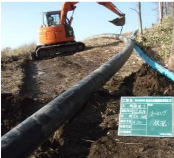
Das HDPE-Rohr mit 355 mm ist eingezogen.
