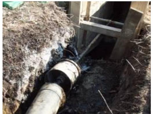
Das 170 m lange HDPE-Rohr DA 355 mm wird an dem Aufweitkopf 520 mm montiert.
