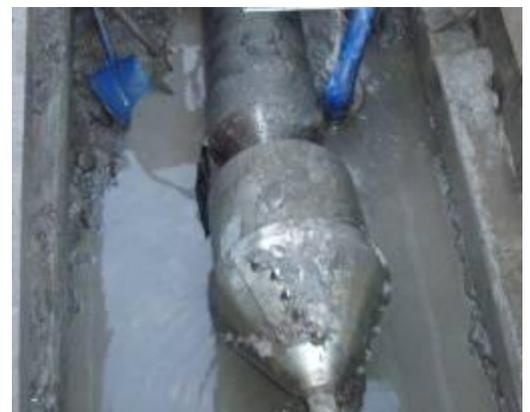
Nach 170 m erreicht der Aufweitkopf 520 mm und das HDPE-Rohr DA 195 mm den TERRA-JET 8522 S. Die Bohrung ist erfolgreich beendet.
