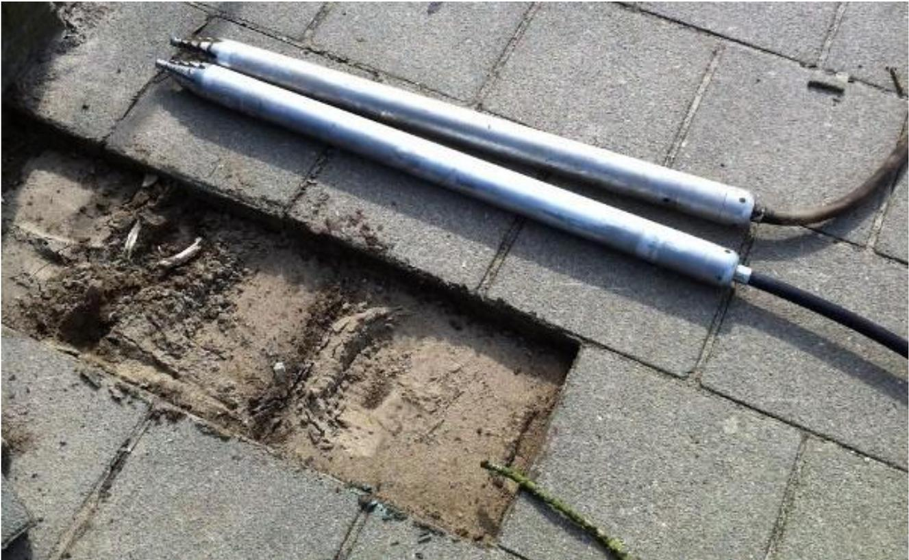
In den Niederlanden sind die Gehwegplatten meistens 0.30 x 0.30 m gross. Da der TERRA-HAMMER T 055 SK nur 0.90 m lang ist, ist es ausreichend, für die Startgruben für Hausanschlüsse nur drei Gehwegplatten zu entfernen. Die so erstellte Startgrube 0.90 m x 0.30 m ist gross genug für diesen TERRA-HAMMER. Die Startgrubentiefe liegt bei 0.55 m.
