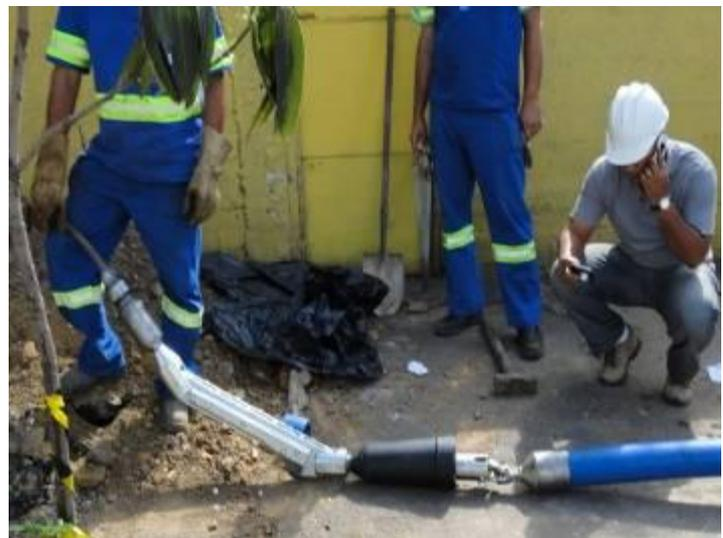
Hier die fertige Montage mit dem 3-schneidigen Rollenmesser DN 100.
