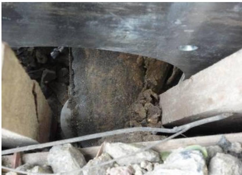
Hier kann man schön sehen, wie das Rollenmesser in der Zielgrube ankommt. Am Schluss der Splittung erreichen die Splittwerkzeuge die Frontbox des TERRA-EXTRACTORS X 400 und können dort mit einfachen Handgriffen demontiert werden.
