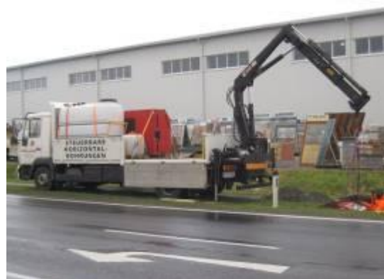
Der TJ 3008 ES wird in die Grube gehoben.
