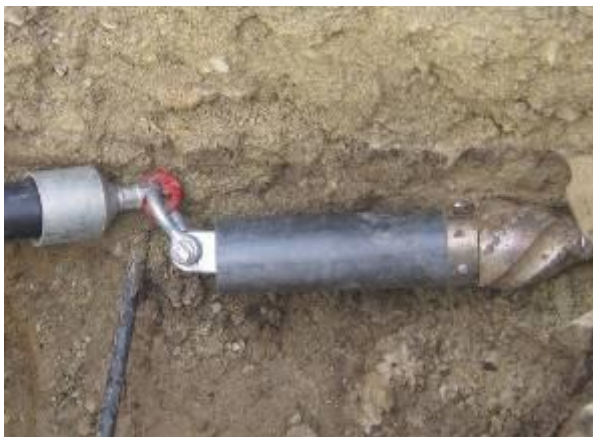
Der Aufweitkopf und das Neurohr vor dem Einzug.
