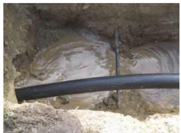
Während des Rohreinzugs tritt kontinuierlich Bentonit-Bohrschlamm hinten aus.
