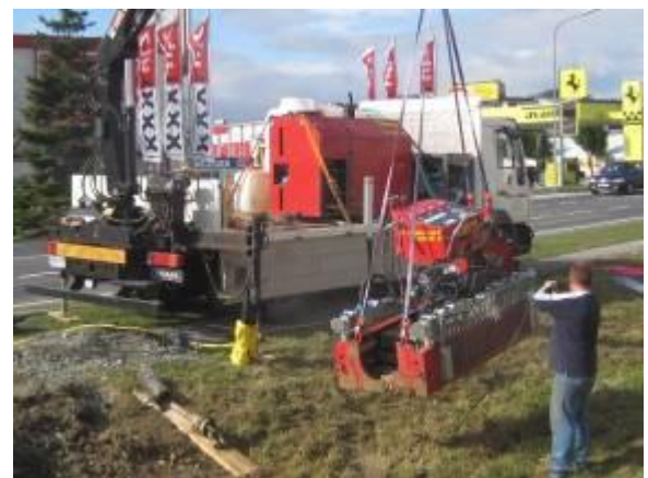
Der TERRA-JET 3008 ES wird nach erfolgreicher Bohrung gereinigt.
