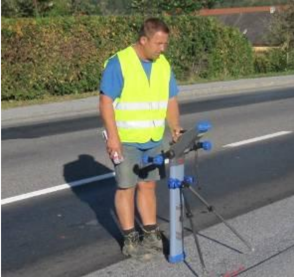
Der Bohrkopf wird während der Pilotbohrung geortet.
