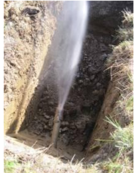
→ Der Bohrkopf kommt zielgenau an.
