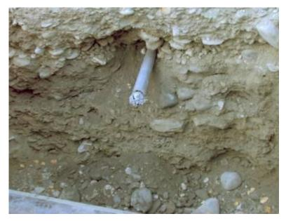
Der TERRA-ROCK Druckluftschlagkopf erreicht die Zielgrube.
