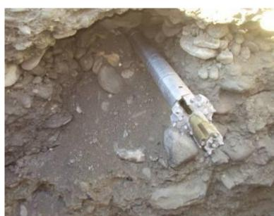
Das Schutzrohr DA 90 mm wurde eingezogen. Anschliessend konnte das Produktrohr eingeschoben werden.
