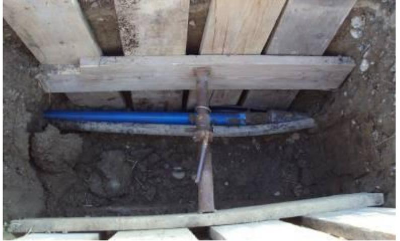
Das Splittmesser, der Aufweitkonus und das neue Schutzmantelrohr bei der Durchfahrung einer Zwischengrube.
