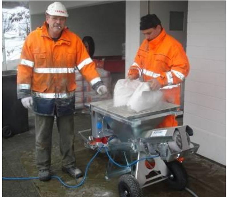
Mit einer Mörtelmischpumpe wird der wärmeleitfähige Injektionsmörtel in das Bohrloch gepumpt.
