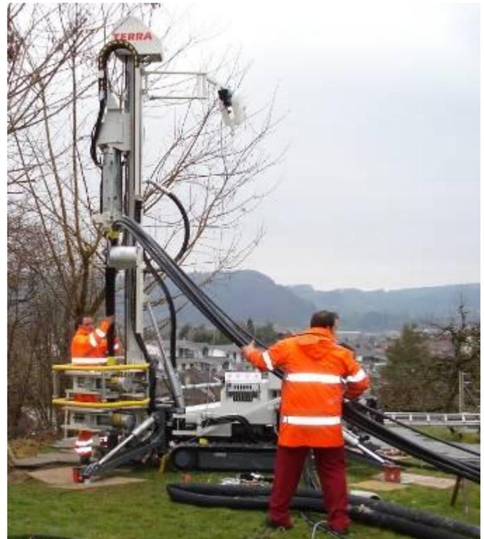
Über die Sondenführung wird die Erdwärmesonde 4 x DA 40 mm mit dem Verpressrohr DA 25 mm und einem 25 kg Gewicht in das Bohrloch eingeführt.
