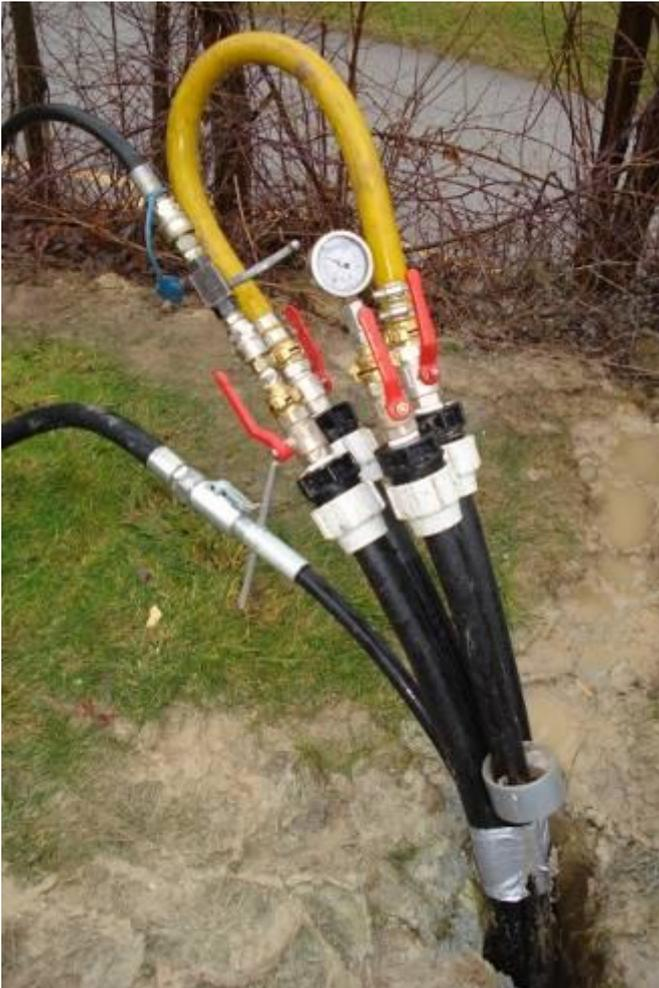
Die Erdsonde ist bis auf die Endtiefe abgelassen. Vor dem Verfüllen des Bohrlochs wird die Sonde mit Wasser aufgefüllt und unter Druck gesetzt.
