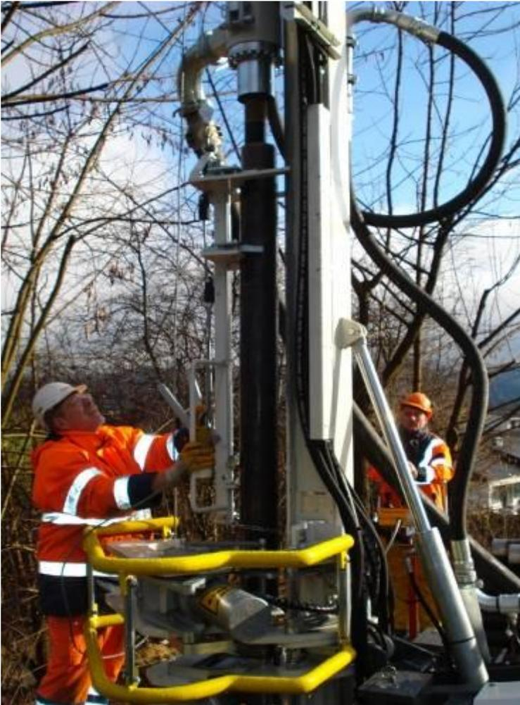
Das Innengestänge wird mittels Handlingsgerät zusammen mit dem Futterrohr eingebaut.
