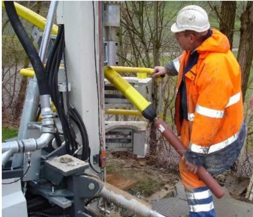
Der Bohrkopf ist fertig ausgebaut. Die Erdsonde wird am unteren Ende mit Klebeband eingebunden.
