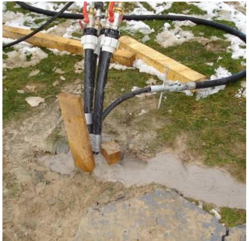
Das Bohrloch wird von unten her komplett verfüllt, bis der Mörtel oben am Bohrloch austritt.
