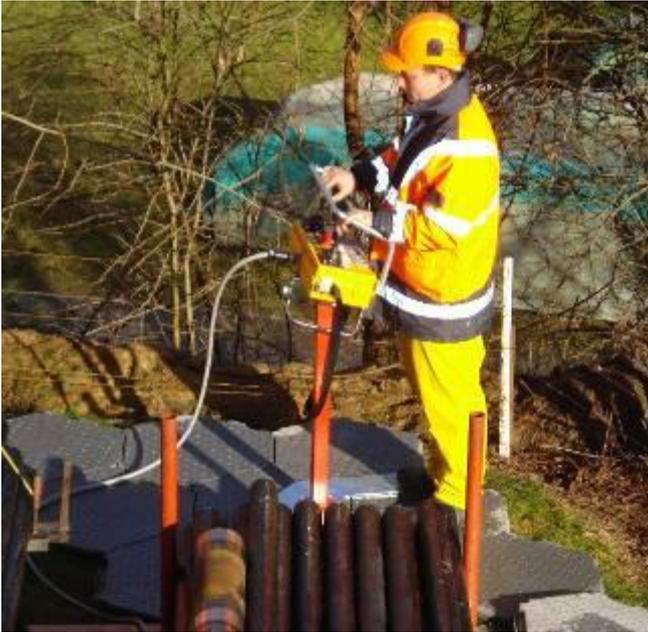
Mit der Fernsteuerung wird die Bohranlage bedient. Sie erlaubt dem Bedienungsmann eine optimale Position mit bester Sicht.
