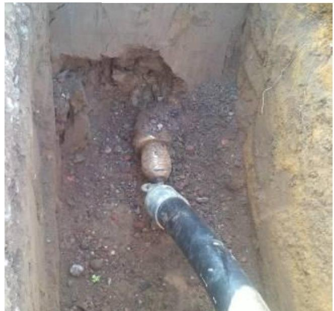
Der Aufweitkopf 160 mm mit HDPE-Rohr DA 110 mm direkt vor dem Rohreinzug.
