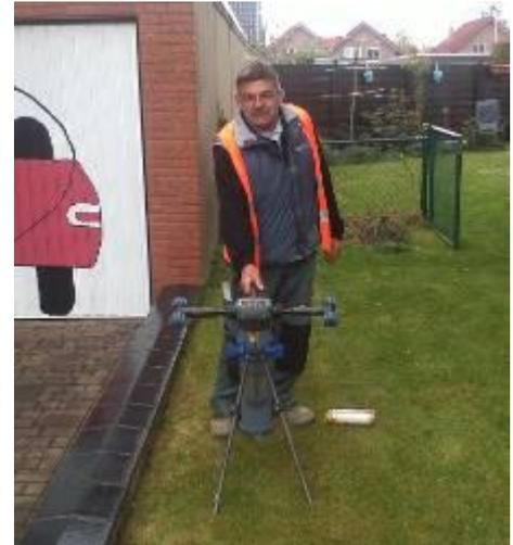
Die Pilotbohrung wird mit dem Ortungssystem i-Track exakt geortet.
