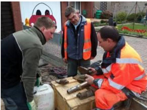
Unterschiedliche Steuerköpfe stehen für unterschiedliches Erdreich zur Verfügung. Die Experten wählen den geeigneten Steuerkopf aus.
