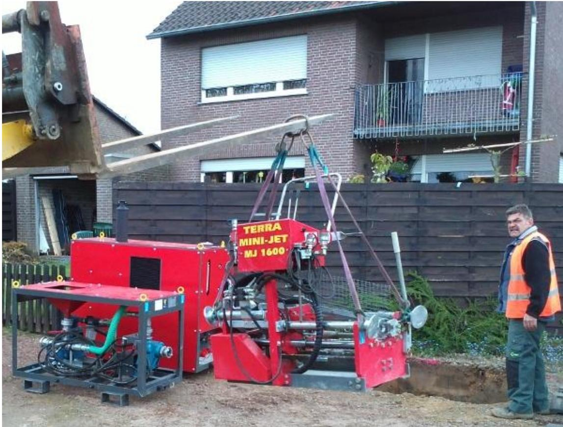
In der deutschen Gemeinde Gangelt im Kreis Heinsberg wurde ein HDPE-Schutzrohr DA 110 mm für ein Elektrokabel über eine Länge von 75 m grabenlos verlegt. Die Verlegung erfolgte aus einer Startgrube nach zwei Seiten. Somit konnte der Aufwand für die Startgrube und die Rüstzeit möglichst gering gehalten werden. Im ersten Abschnitt von 35 m wurde die Bohrung unter einem Privatgrundstück und im zweiten Abschnitt von 40m unter einem öffentlichen Zufahrtsweg geführt.
