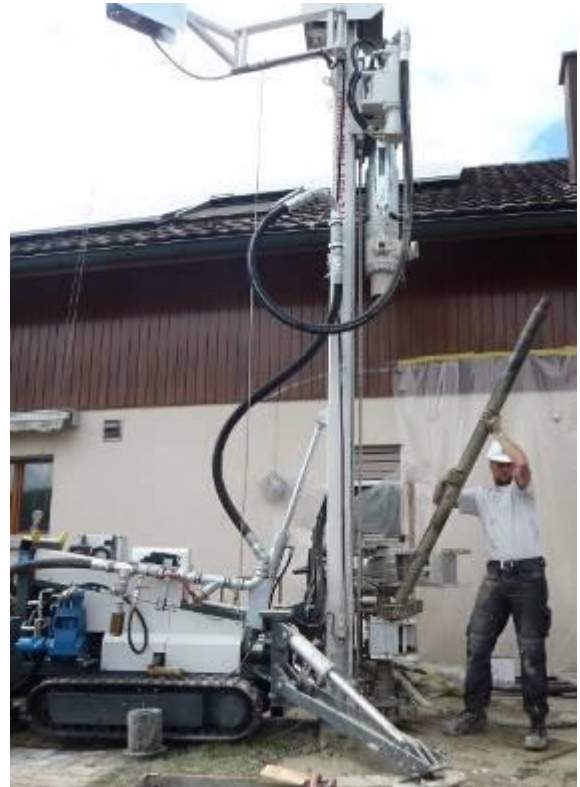
Nachdem der Imlochhammer die Endtiefe von 100 m erreicht hat, werden die Bohrgestänge und der Imlochhammer ausgebaut.
