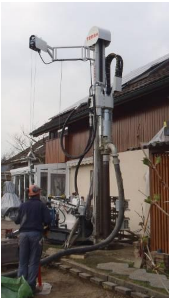
Auf den ersten 46 m werden die Futterrohre DA 152 mm und die Bohrgestänge DA 89 mm mit dem Imlochhammer zeitgleich abgeteuft.
