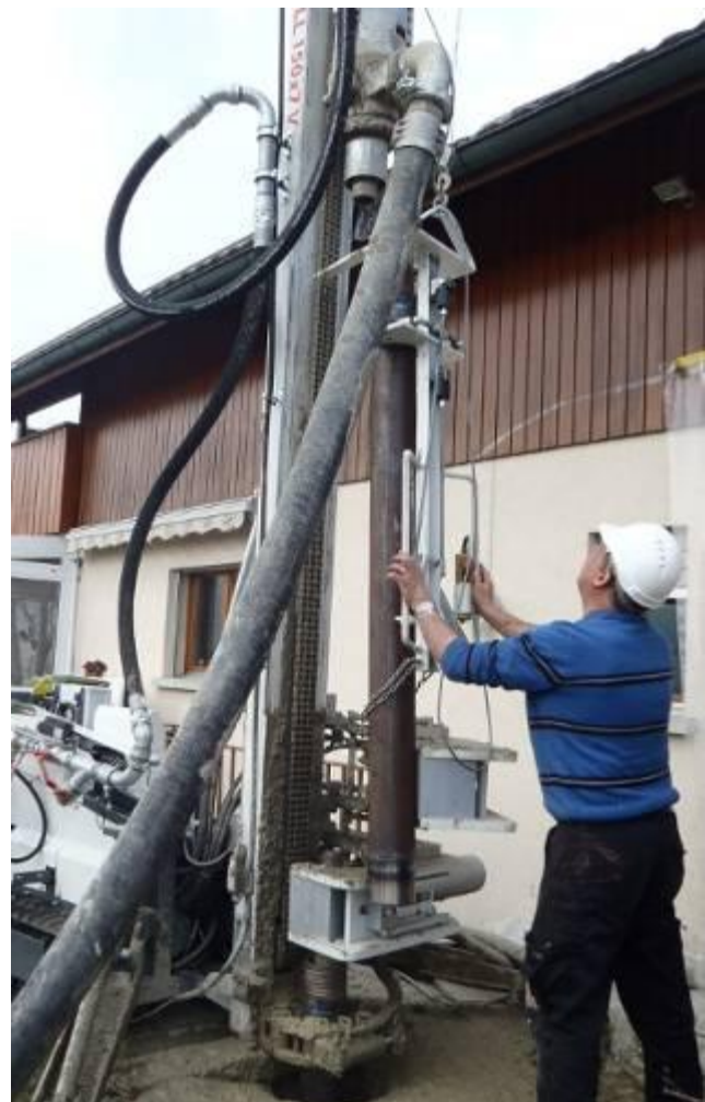
Ein neues Paar Futterrohr mit innenliegendem Gestänge wird mit der Handling-Vorrichtung eingelegt und hydraulisch verschraubt.
