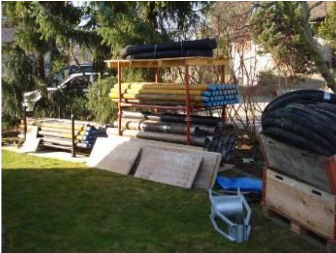
Die 2 m langen Gestänge DA 89 mm und Futterrohre 152 mm werden im Vorgarten gelagert.
