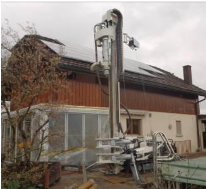
Die zweite Bohrung wird in 6 m Abstand auf 120 m Bohrtiefe abgeteuft.
