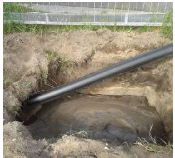
Das HDPE-Rohr DA 125 mm wird eingezogen. Der Bohrschlamm mit dem ausgetragenen Sand läuft in die Zielgrube.
