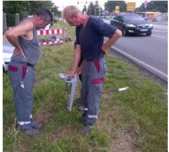
Während der Pilotbohrung wird der Bohrkopf genau geortet.
