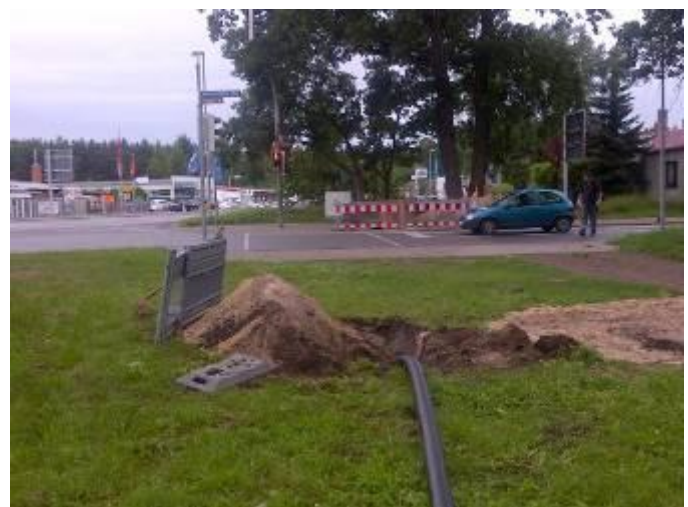
Das HDPE-Rohr DA 125 mm wird über 40 m unter dieser Strasse gezogen.
