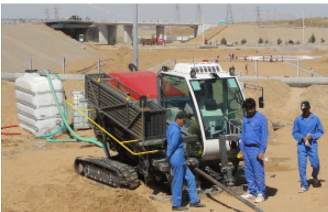
Der TERRA-JET 8522 S während einer Pilotbohrung.
