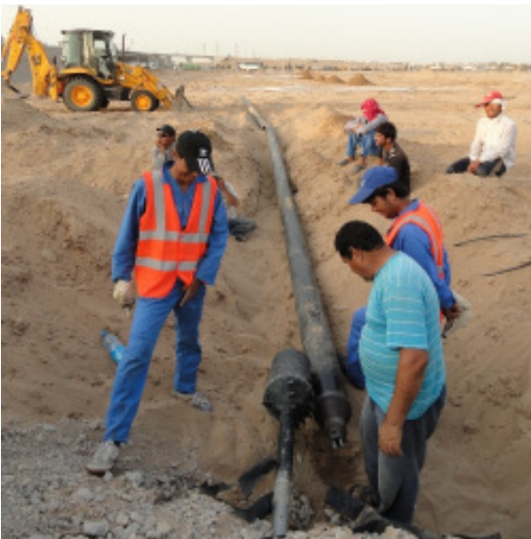
Das Stahlrohr DA 324 mm wird mit dem Aufweitkopf \varnothing 420 mm verbunden. Anschliessend beginnt der Rohreinzug.
