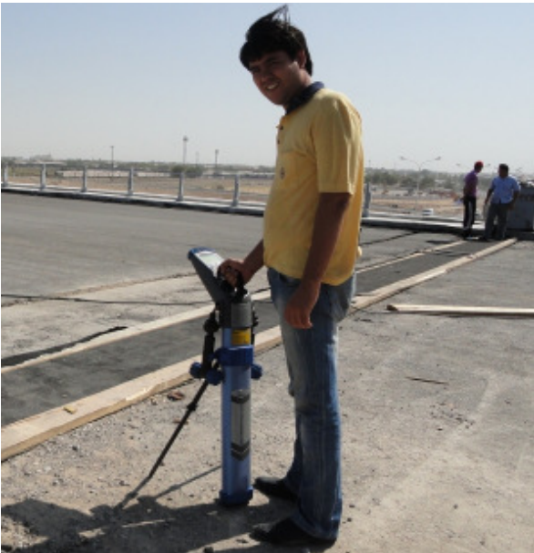
Eine Pilotbohrung wird geortet.
