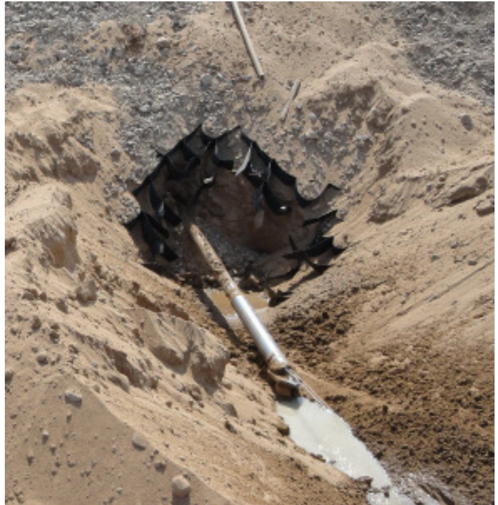
Der Bohrkopf erreicht die andere Strassenseite.
