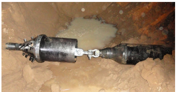
Das Stahlrohr DA 324 mm erreicht die andere Strassenseite. Es wurde über eine Gesamtlänge von 65 m eingezogen.
