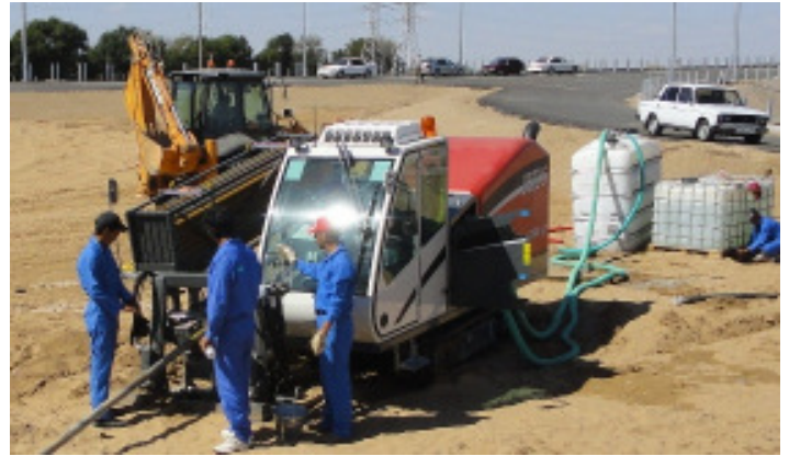
Der TERRA-JET 8522 S während der Bohrarbeiten. Die Komfort-Fahrerkabine wird mit einer leistungsstarken Klimaanlage gekühlt (Kühlleistung über 6 kW).
