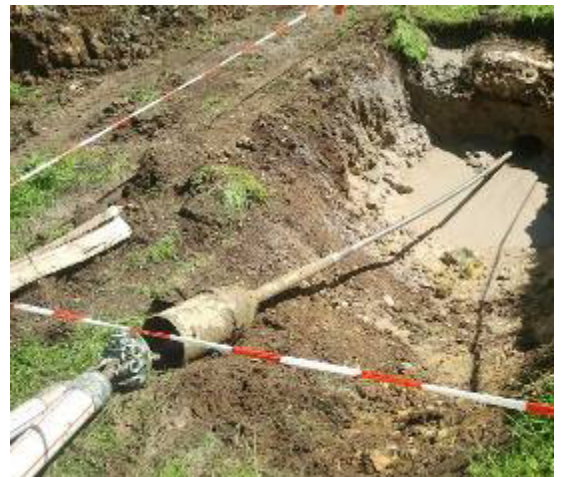
Blick auf die Zielgrube vor dem Rohreinzug.
