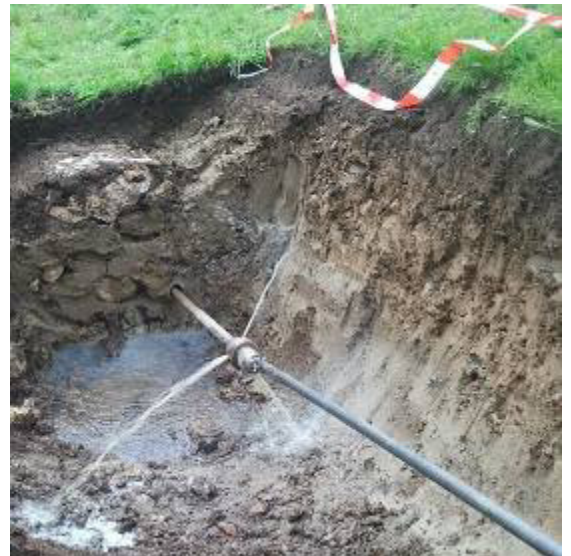
Die Zwischenaufweitung \varnothing 215 mm beginnt.
