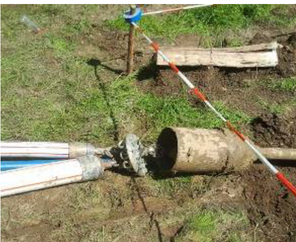
Der Aufweitkopf \varnothing 360 mm mit Rohrbündel (1x DA 132 mm, 1x DA 92 mm, 1x DA 63mm)
