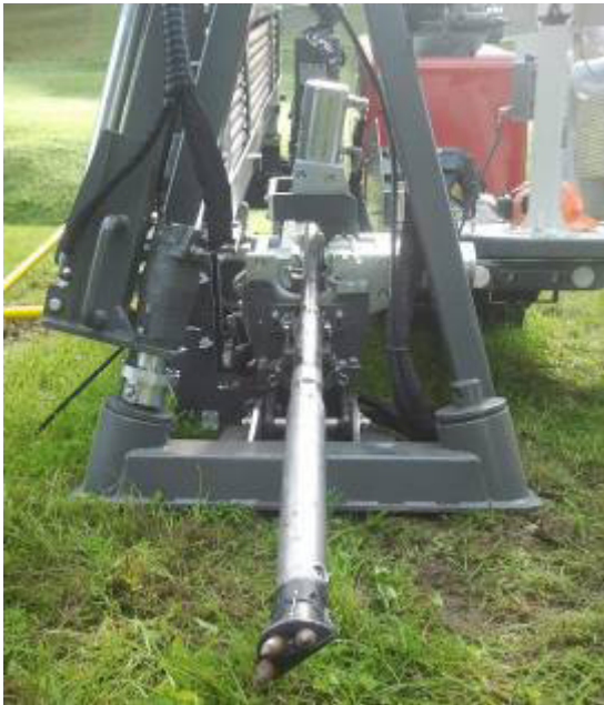
Start der Pilotbohrung. Der 3-Fingerkopf eignet sich für harte und steinige Böden.
