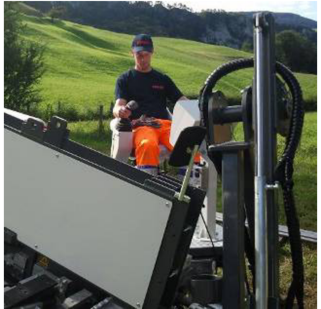
Der Bedienungsmann konzentriert sich auf die Pilotbohrung.
