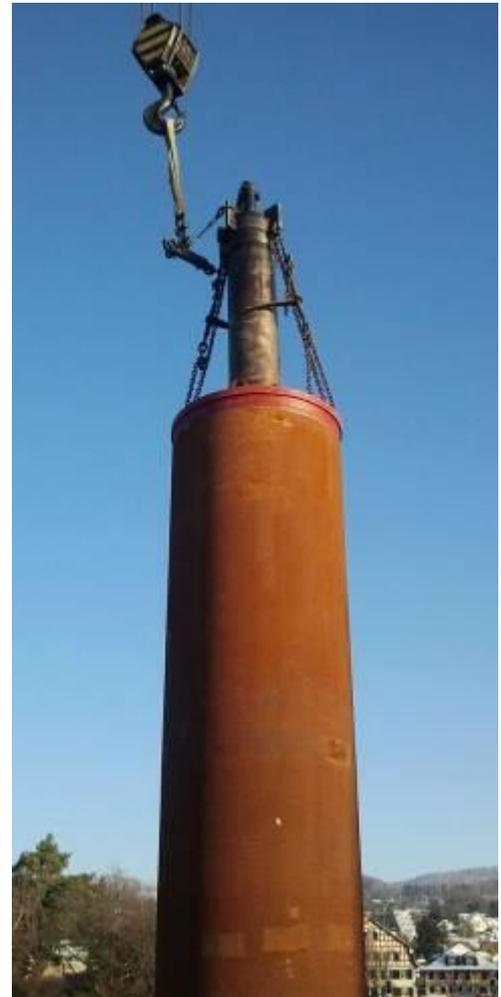
Der Stahlrohrpfosten  $\varnothing$  1016 mm wird mit dem TERRA-HAMMER TR 360 eingerammt.
