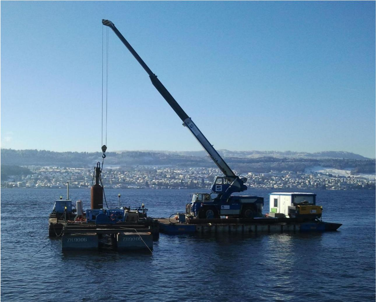
Um die bestehenden Leitpfähle bei der Landeanlage der Zürichseefähre in Meilen zu verstärken, hat die auf Wasserbau spezialisierte Firma Willy Stäubli Ing. AG einen Stahlrohrpfosten  $\varnothing$  1016 mm (L=36m) eingerammt. An das Stahlrohr wurden vorab diverse Laschen angeschweisst und anschliessend liegend unter einem Ponton an den Einsatzort transportiert. Dort angelangt stellte man den Pfahl vertikal und richtete ihn exakt aus.
