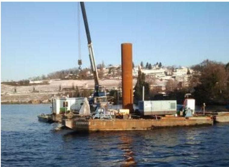
Anschliessend wurde der Pfosten mit dem TERRA-HAMMER TR 360 eingerammt. Nach den Rammarbeiten, trennte ein Taucher den Pfahl in 22 m Tiefe und der im Boden verbleibende Pfahl wurde armiert und ausbetoniert. Der Einbau einer Rohrstrebe  $\varnothing$  600 mit speziellen Briden, welche eine kraftschlüssige Verbindung zur bestehenden Anlage bildet, erhöht die Sicherheit der Leitpfähle.
