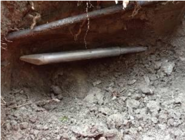
Nach 22 m erreicht der Presskopf die Zielgrube.
