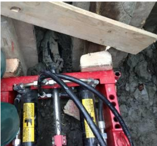
Die Zwischenaufweitung ist erstellt. Der Aufweitstern erreicht die Pressgrube.
