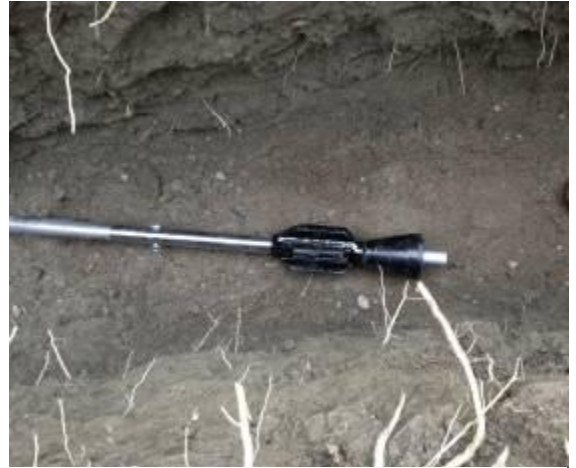
Die Zwischenaufweitung wird mit einem Aufweitstern und einer Aufweitlocke auf 90 mm Durchmesser erstellt.
