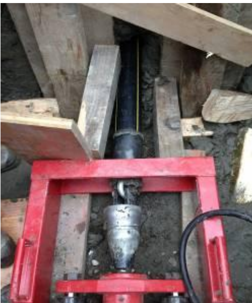
Die Zwischenaufweitung ist erstellt. Der Aufweitstern erreicht die Pressgrube.
