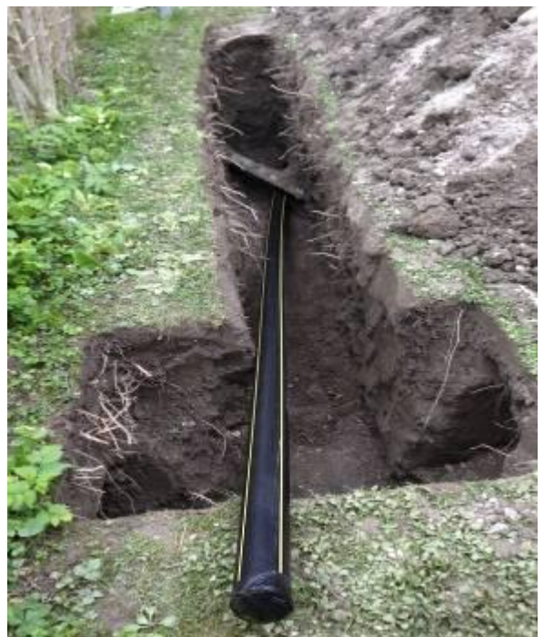
→ Zielseitig wird die eingezogene Gasleitung an die Hauptleitung angeschlossen.
