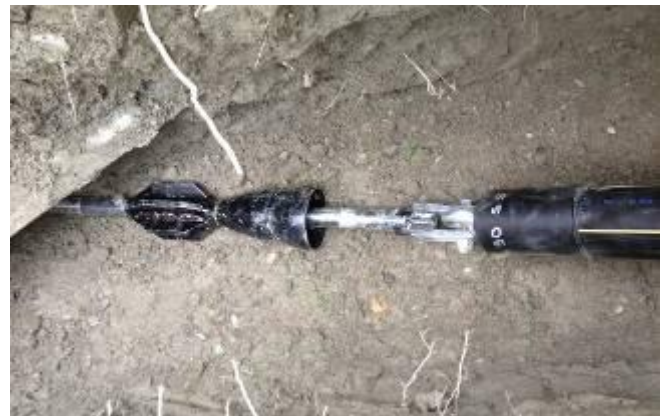
Die Endaufweitung auf \varnothing 110 mm beginnt. Das HD-PE Rohr \varnothing 90 mm wird gleichzeitig eingezogen.
