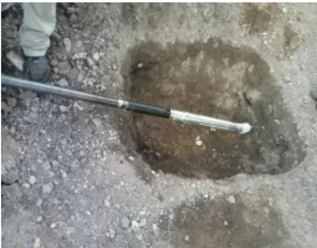
Für den schweren Boden – aufgeschütteter und kiesiger Grund – wurde ein 3-Fingerkopf verwendet, welcher diesen Untergrund mühelos bewältigte.
