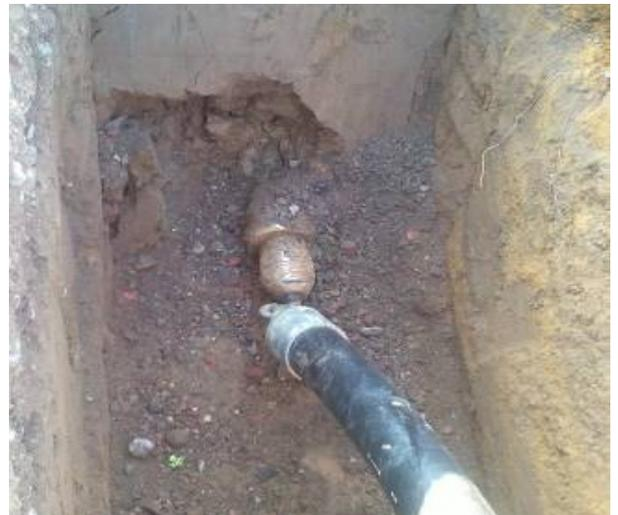
Der Rohreinzug erfolgte mit einem mit Hartmetall-Zähnen bestückten Aufweitkopf  $\varnothing$  115 mm. Dank der Kraftübertragung des Doppelzylinder-Prinzips, welches die TERRA AG neuentwickelte, konnte das Rohr mühelos durch den harten Boden eingezogen werden.
