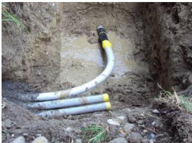
Das Kabelschutzrohr ist fertig eingezogen und bereits mit dem Anschlussrohr verbunden.
