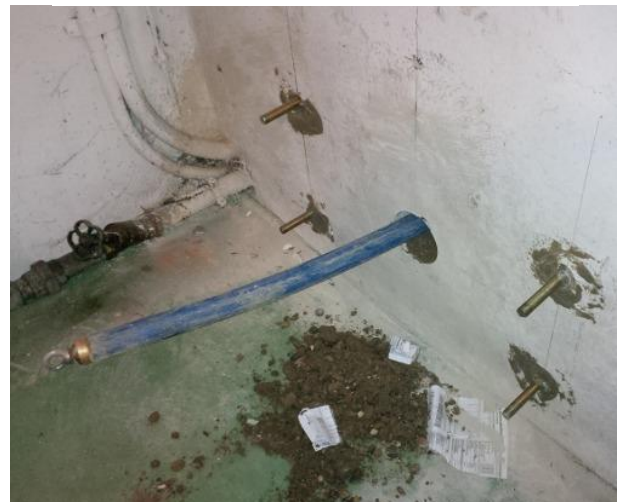
Nach dem Rohreinzug wird der TERRA-JACK demontiert. Er kann leicht von zwei Personen getragen werden. Die Wasserleitung wird im Haus angeschlossen.
