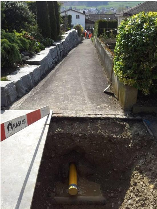
Der Aufweitkopf kommt mit dem Rohr in der Startgrube an.
