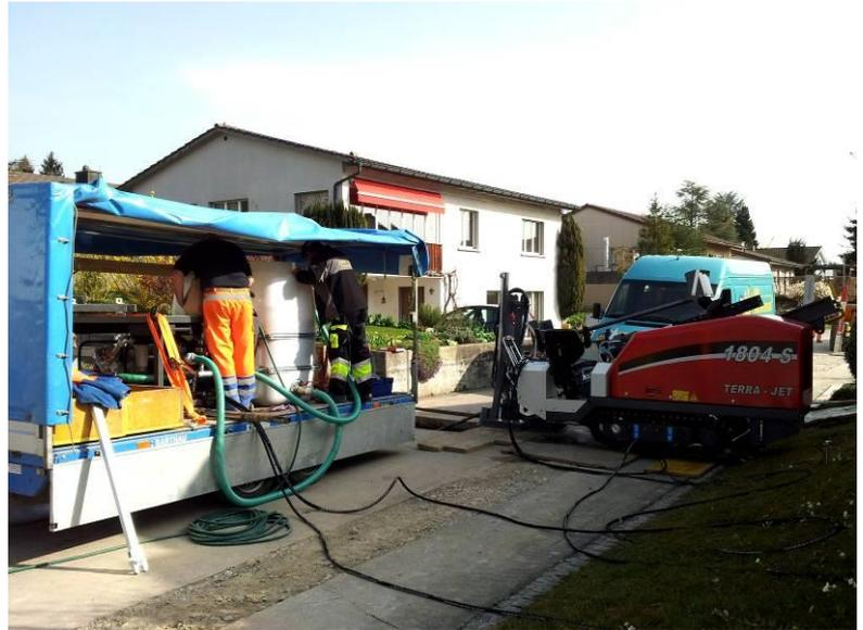
Misch- und Pumpstation, sowie Tank und Werkzeug sind fix auf einem Anhänger angeordnet. Das Einscheren des Bentonitpulvers in den Wassertank erfolgt bequem an der Misch- und Pumpstation.
