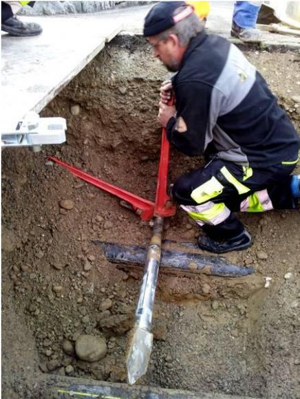
Nach zielgenauer Ankunft wird das Sondengehäuse mit dem Bohrkopf entfernt und ein Aufweitkopf  $\varnothing$  160 mm montiert. Hinter dem Aufweitkopf wird direkt das HDPE-Rohr  $\varnothing$  125 mm angekoppelt und miteingezogen.
