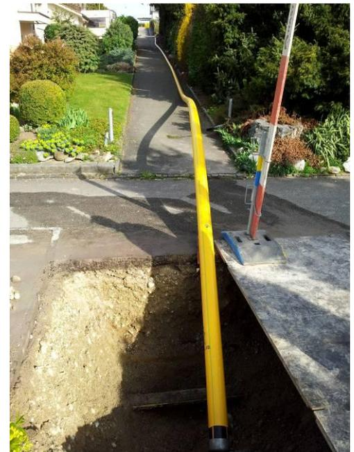
Das fertig eingezogene Rohr in der Zielgrube. Die ganze 49 m Bohrung inklusive Rohreinzug wurde innerhalb eines halben Tages erstellt.
