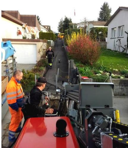
Es war nicht möglich, die Maschine bergseitig des mässig steilen Bohrtrassees zu platzieren. Daher wurde zu Beginn die ganze Flexibilität des Bohrgestänges ausgeschöpft und pro Gestänge jeweils die erlaubten 9 % Richtungsänderung pro Gestänge gesteuert.
