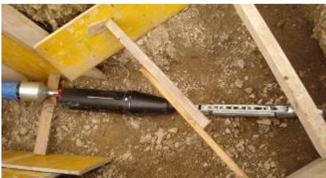
Das Rollenschneidmesser mit angehängtem Aufweitkonus, Schutzhülse über der Zugkraftmesseinheit sowie Neurohr.
