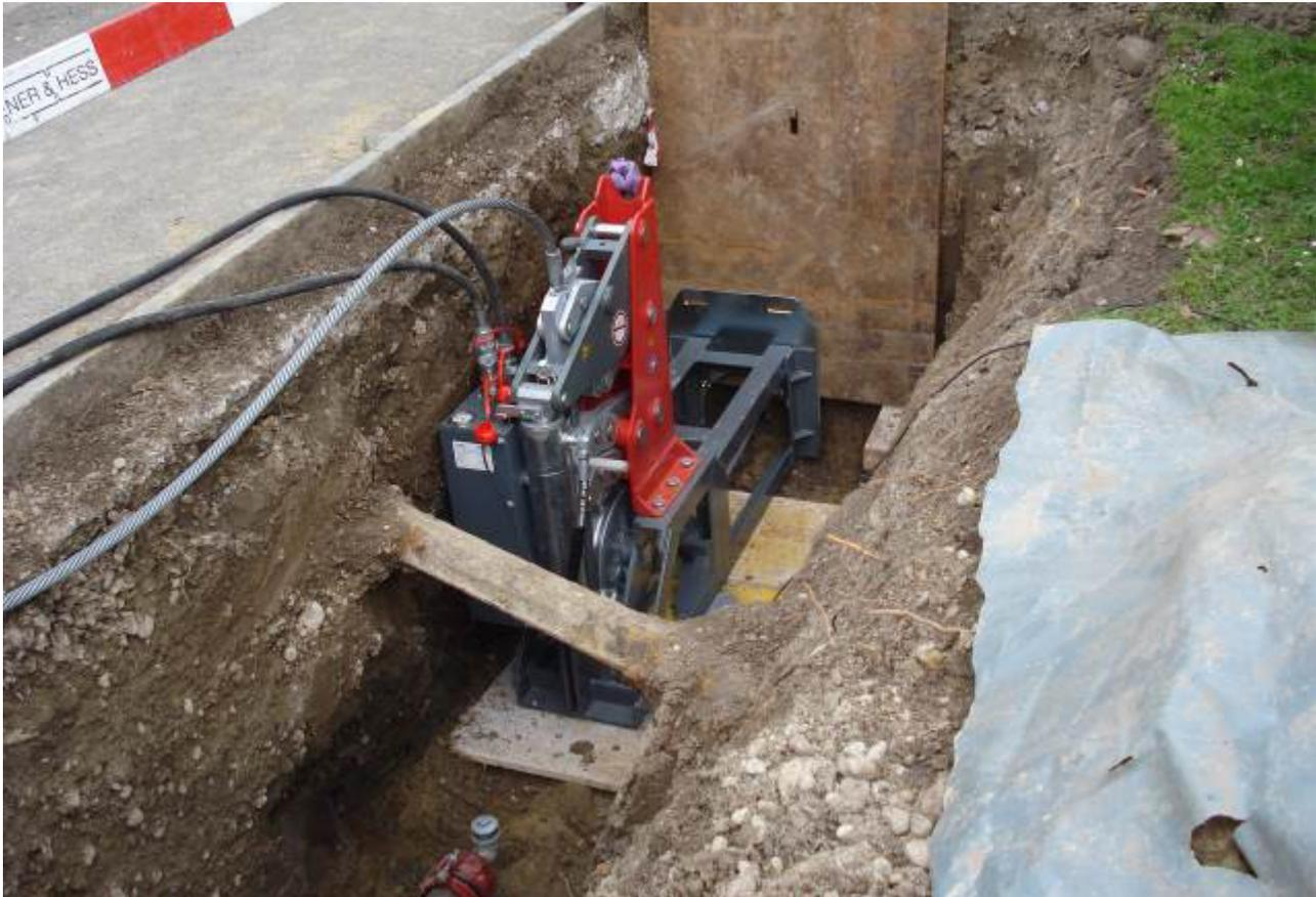
Die Erneuerung einer Trinkwasserleitung mittels Berstlining-Verfahren wurde in Stäfa, Kanton Zürich, mit dem Seilberster TERRA-EXTRACTOR X 400 ausgeführt. Die Altleitung aus Grauguss DN 100 wurde mit einem Rollenschneidmesser aufgeschnitten. Als Neurohr wurde ein Schutzmantelrohr HD-PE DA 160 mm eingezogen.
