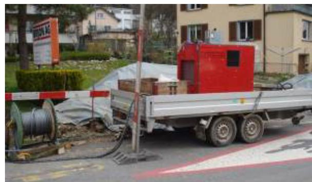
Der Seilberster wird über ein Hydraulikaggregat angetrieben. Das Zugseil ist auf einer Trommel aufgewickelt.
