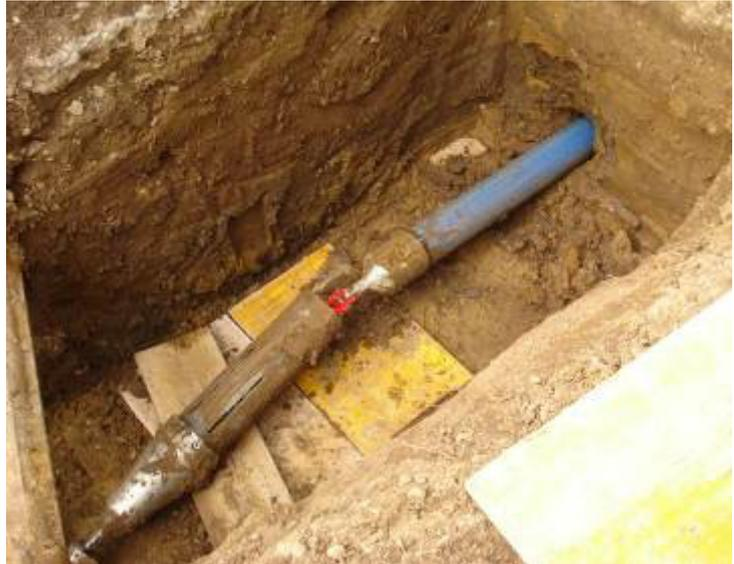
Der Seilberster wurde in der Zuggrube zurück versetzt, damit der Aufweitkonus und das Schutzrohr demontiert werden konnten. Das Schutzmantelrohr kann nun an das bestehende Trinkwassernetz angehängt werden.
