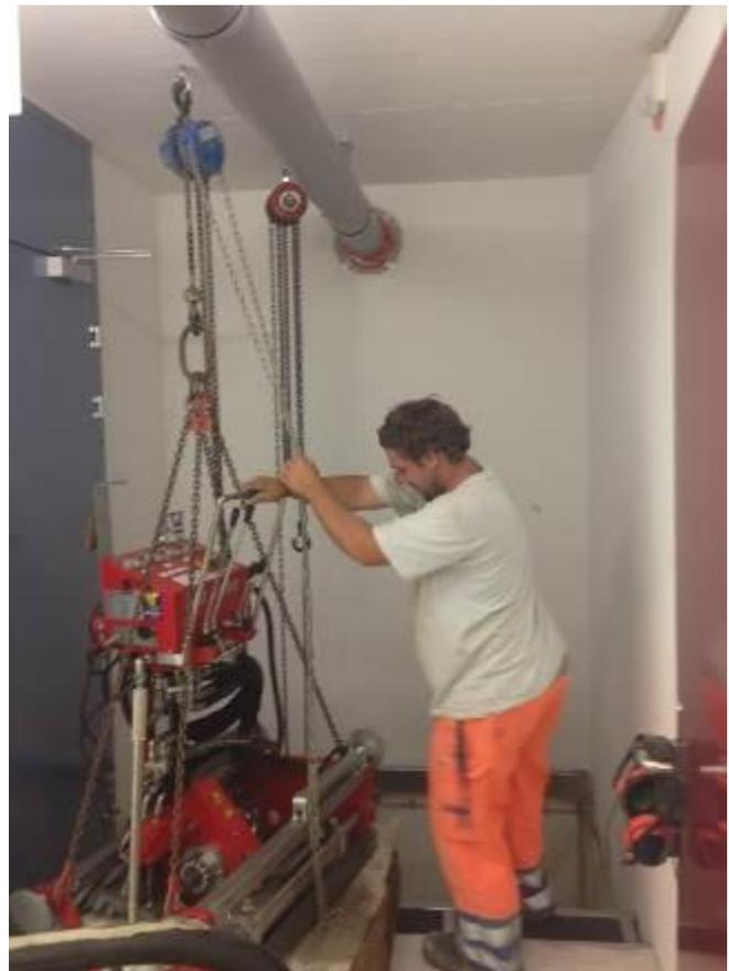
Die Bohrlafette wird mittels Kettenzügen in die Bohrposition gebracht.
