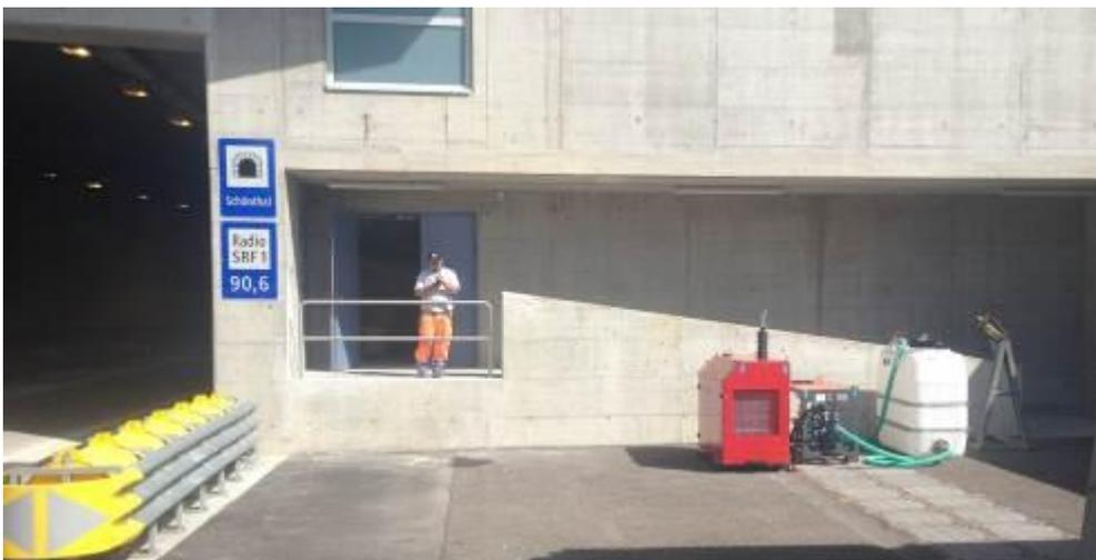
Beim Tunneleingang wurde das Hydraulikaggregat, die Mischstation und der Spülungstank installiert.
