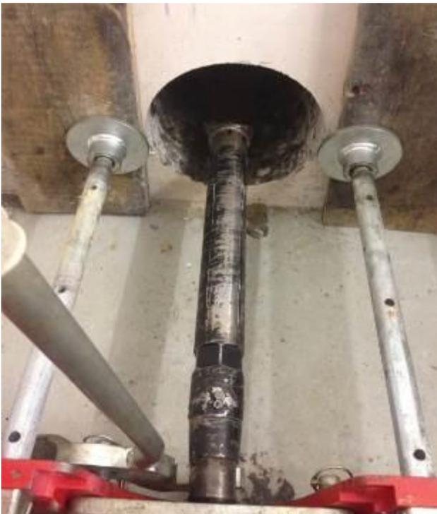
Die Bohrlafette ist fertig installiert und das Sondengehäuse mit Steuerkopf montiert.
