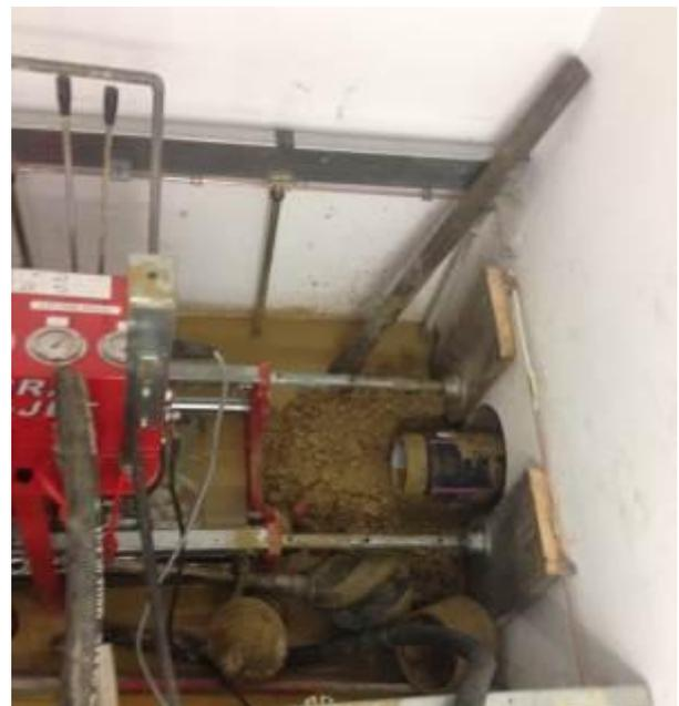
Das fertig eingezogene Schraubrohr. Die Kernbohrung wurde zuletzt mit Schnellmörtel verfüllt.
