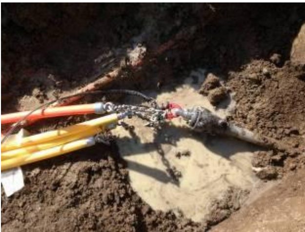
Die Pilotbohrung erreicht zielgenau die Hauptleitung in der Zielgrube. Ein 3-Finger-Bohrkopf wurde dafür verwendet.
