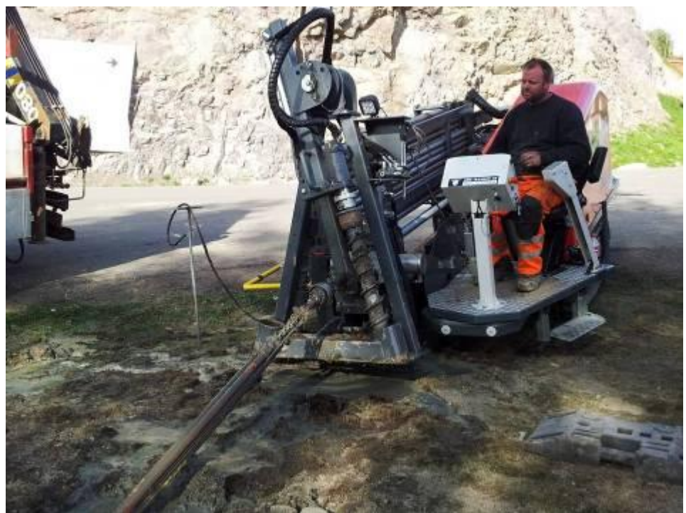
Eigentümer und Bohrmeister Henrik Mikkelsen zieht die Rohre weiter zurück durch Zurückfahren der Maschine nach einem schnellen und problemlosen Aufweiten mit gleichzeitigem Rohreinzug.
