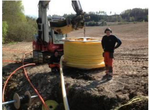
Die einzuziehenden PE-Rohre hängen an einem Haspel am Bagger bereit für den Aufweitvorgang mit direktem Rohreinzug.
