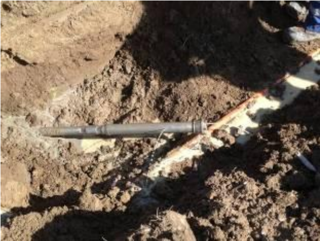
Die Pilotbohrung erreicht zielgenau die Hauptleitung in der Zielgrube. Ein 3-Finger-Bohrkopf wurde dafür verwendet.
