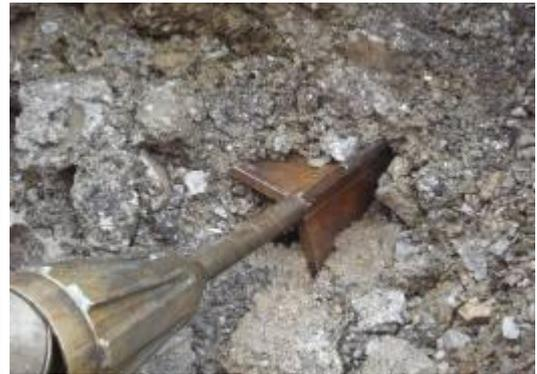
Das Splittmesser spaltet das alte Zementrohr auf.
