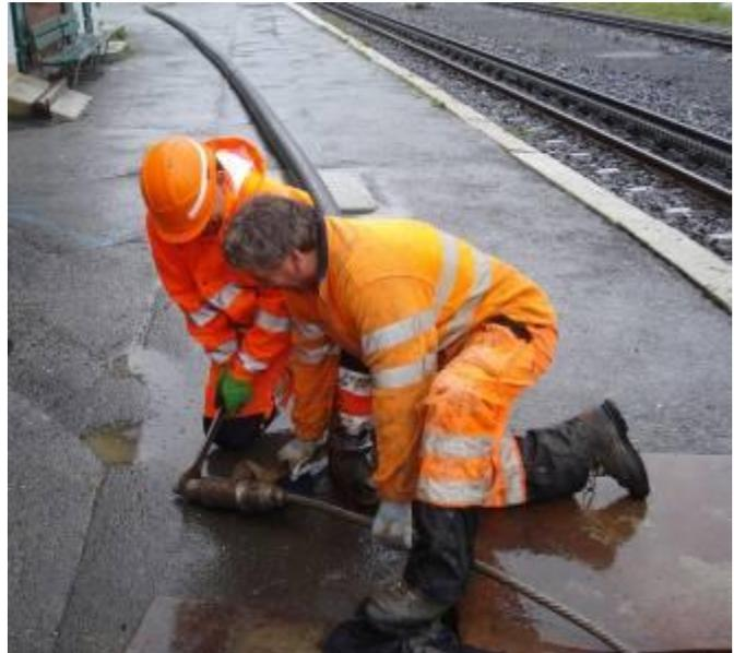
Auf das Zugseil wird die Seilkupplung montiert.
