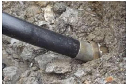
Der Aufweitkonus drückt das Altrohrmaterial zur Seite und erstellt einen Kanal für das Neurohr.
