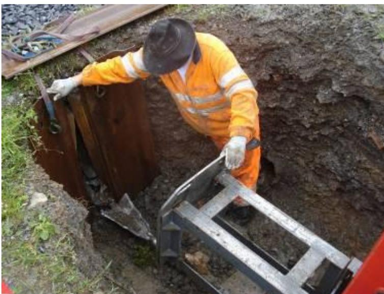
Das Splittmesser kommt in der Zugrube an.
