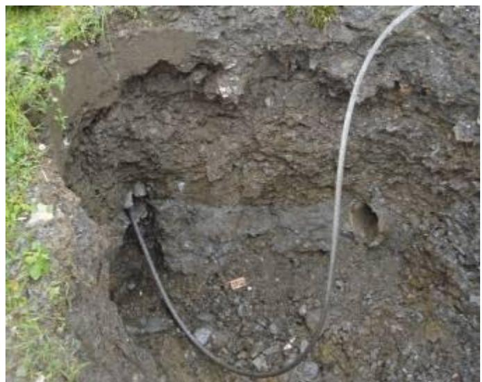
Das Zugseil wird durch den Seilberster und anschliessend durch das Altrohr eingezogen.
