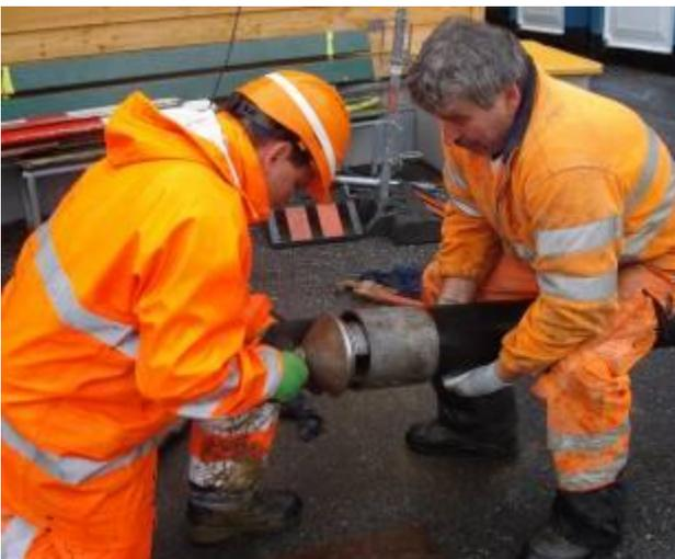
Der Zugkopf wird an das Neurohr montiert.
