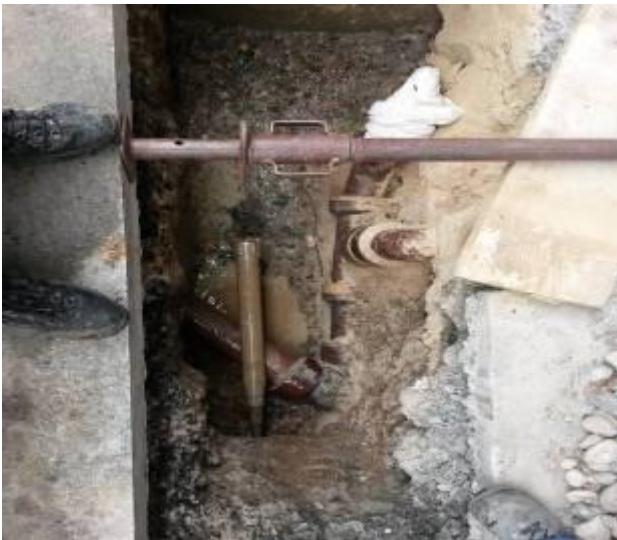
Blick von oben in die Zielgrube. Gut erkennbar die parallele Ausrichtung zu den vorhandenen Tonrohren.
