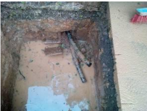
Die 2 x DA 63 mm Schutzrohre nach dem Einzug.
