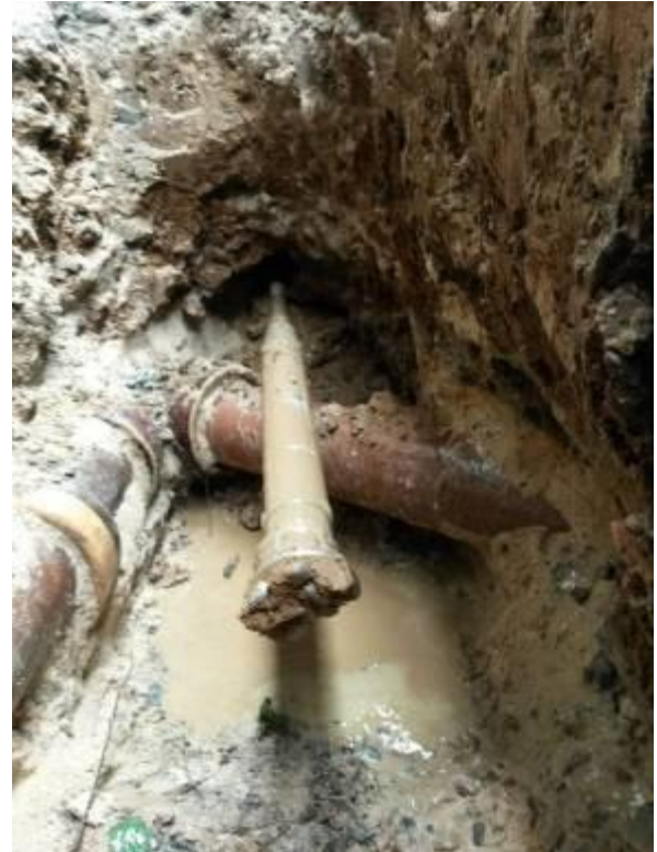
Der Bohrkopf erreicht sein Ziel millimetergenau. Der montierte 3-Fingerkopf wurde vorher ausgewählt, um festes Erdreich und leichten Fels bohren zu können.
