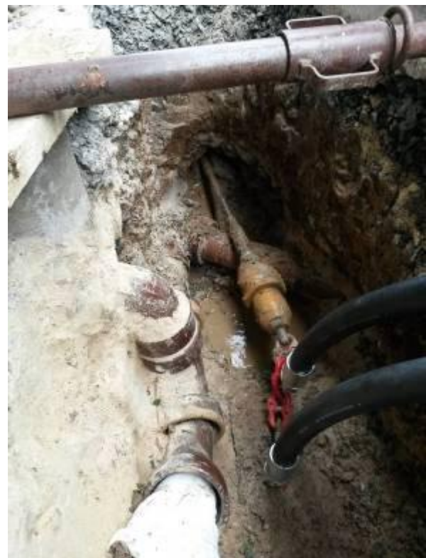
Das angehängte Rohrbündel vor dem Rohreinzug.
