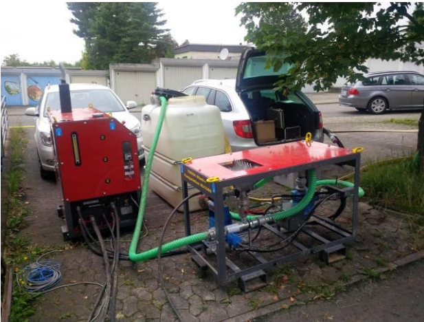
Die Module der Grubenbohranlage sind auf engstem Raum platziert.
