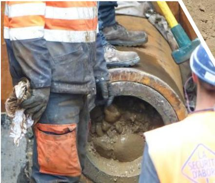
Links: Im Innern des gerammten Stahlrohrs ist das eindringende Erdreich gut zu erkennen.
