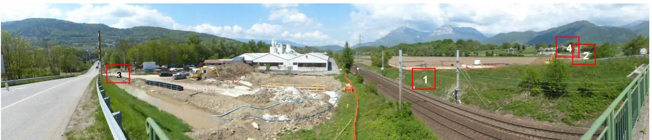
Der französische Tiefbauspezialist SOGEA 38 ist damit beauftragt worden, mehrere Rammungen mit den Durchmessern 400 mm und 600 mm durchzuführen. Diese Rammungen dienen zum Unterqueren der Autobahn A41, einer Autobahnauffahrt, der Doppelspurbahnstrecke (RFF-SNCF, Verbindung zwischen Grenoble und Chambéry) sowie eines Radwegs und einer Werkzufahrt.
