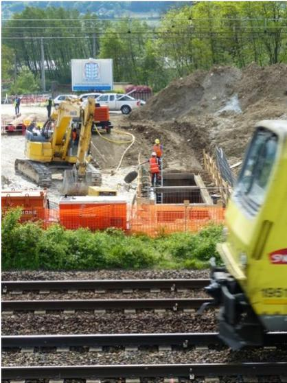
Die 52 m Rammung mit  $\varnothing$  600 mm unter dem Bahngleis und dem Radweg konnten ohne ein zwischenzeitliches Entleeren der Stahlrohre durchgeführt werden mit einer Vortriebsgeschwindigkeit von 35 m/h bis 12 m/h auf den letzten Metern.
