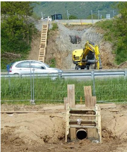
Links: Die verlegten 39 m Rohre  $\varnothing$  600 mm unter der Autobahn.
