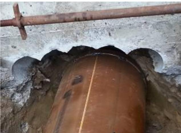
Zur Reduzierung der Mantelreibung wurde hier mit einem inneren und äußeren Schneidring gearbeitet.
