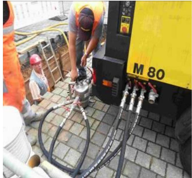
Der Öler wird an den Kompressor und die TR 220 angeschlossen.
