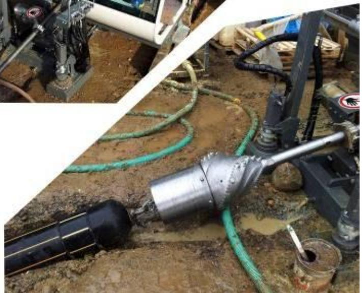
Aufgrund des harten Untergrundes wurden drei Zwischenaufweitungen erstellt. Nach Zwischenaufweitungen auf 215 mm, 300 mm und 360 mm wurde das Rohr mit dem Räumter Ø 360 mm innerhalb von drei Stunden erfolgreich eingezogen.
