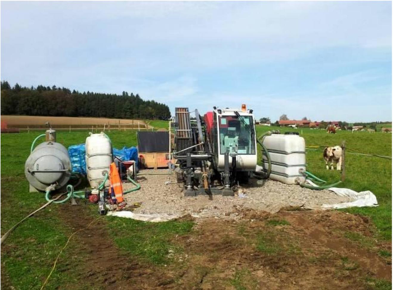
Übersicht auf die Installation des TERRA-JET TJ 8522 S und die zusätzliche externe Mischstation bei der zweiten Bohrung (Bild oben). Bei der Unterquerung des Baches (Bild unten) musste abschnittsweise durch Sandstein gebohrt werden. Die Bohrung, Aufweitung und Rohreinzug (Bild rechts) konnten erfolgreich fertig erstellt werden. Dies nicht zuletzt dank des neuen Multipin-Steuerkopfes.
