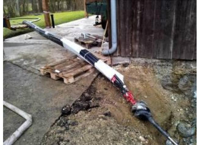
Unterhalb des Gebäudes war wie erwartet das Orten durch passive Interferenz (Störungen) erschwert. Da allerdings keine Leitungen im Umfeld des Bohrpfad es waren, konnte dank der relativ störungsun anfälligen Neigungsanzeige den Umständen entsprechend zielgenau gebohrt werden. Das Bild oben zeigt den Bohrkopf bei Ankunft in der Zielgrube.
