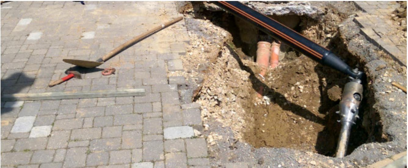
Bild 4: Nach erfolgreicher Erstellung der Pilotbohrung wurde direkt das HDPE-Produktrohr mit einem Aussendurchmesser von 160 mm eingezogen. Das Bild oben zeigt den Aufweitkopf  $\varnothing$  215 mm mit angehängtem HDPE-Rohr  $\varnothing$  160 mm vor Beginn der Aufweitung mit gleichzeitigem Rohreinzug.
