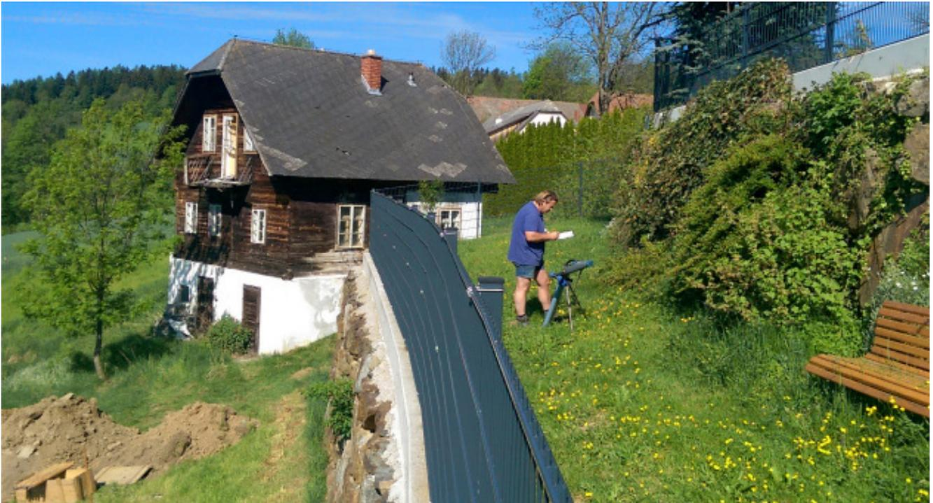
Bild 2: Der Bohrkopfverlauf wird während der Pilotbohrung mittels eines Ortungsgeräts überwacht. Die Steinmauern und die Zäune erschwerten das Orten geringfügig. Durch die Überwachung der Neigungsänderung für jedes Gestänge an Monitor der Grubenlafette konnte jedoch zielgenau gebohrt werden.
