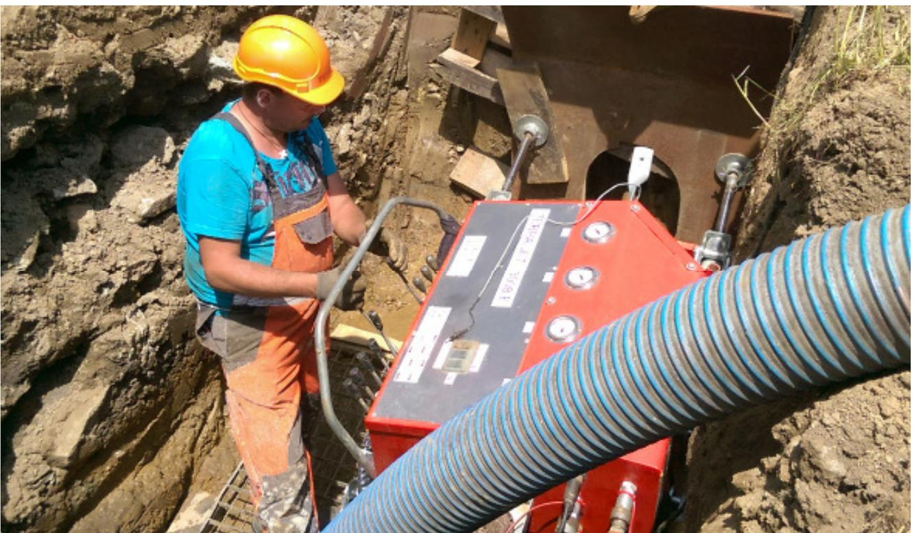
Bild 3: Bohrmeister Jürgen Ertl beim Bedienen des TERRA-JET TJ 3008 ES. Hydraulische Zylinder sorgen für eine sichere und feste Verspannung der Grubenlafette in der Startgrube. Das anfallende Bentonit wurde jeweils mit einem Saugfass abgesaugt und entsorgt.
