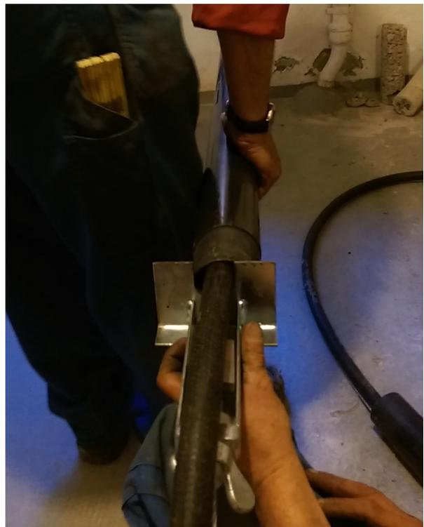
Die Schutzrohre Ø 75 mm werden sofortverrohrt und mit der Seilklemme sicher verspannt.
