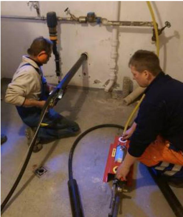
Der TERRA-HAMMER T 080mini SK mit übergrosser Endhülse Ø 90 mm wird im Keller eingerichtet.
