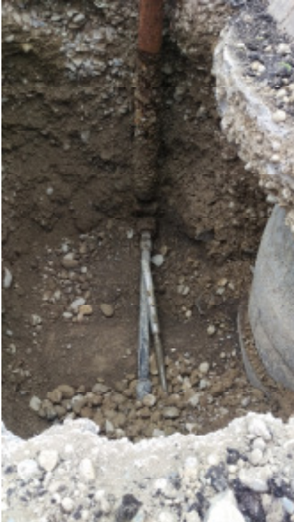
Bild 2: Das Pressgehäuse erreicht die Grube zielgenau.
