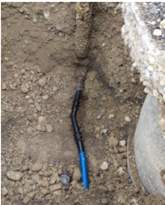
Bild 7: Die defekte Wasserleitung wurde beim Hauptleitungsschieber abgetrennt und die neue Leitung angehängt.
