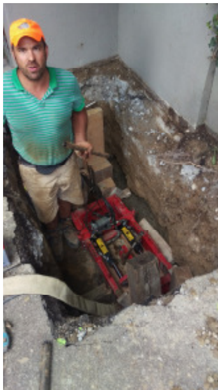
Bild 4: Firmeninhaber Martin Hofer bedient den TERRA-JACK. Er ist sichtlich begeistert von der Leistungsfähigkeit dieser Richtpressanlage.
