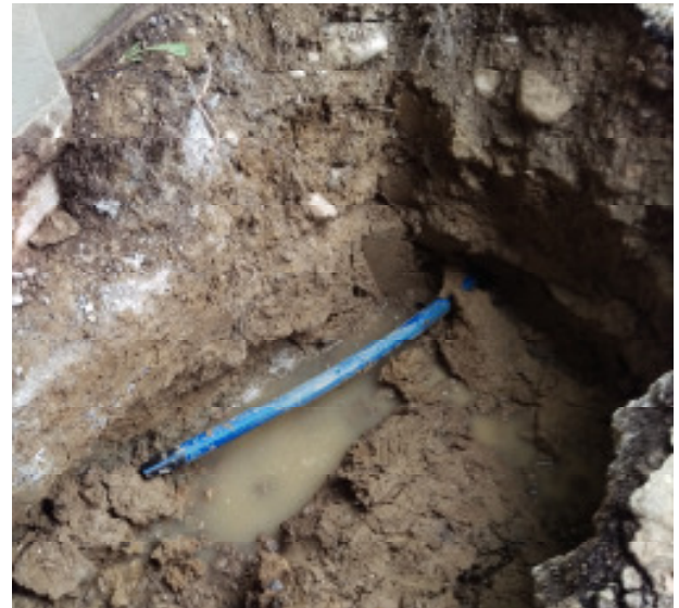
Bild 6: In der Bildmitte das fertig eingezogene Schutzmantelrohr DA 50 mm.
