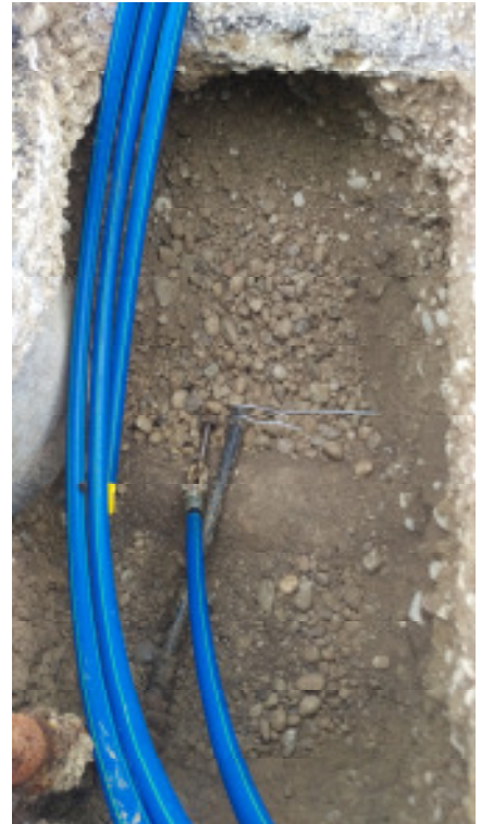
Bild 3: Nach erfolgter Pilotpressung wird der Presskopf demontiert und anschliessend ein Aufweitstern sowie die Aufweitglocke montiert. Dahinter das einzuziehende Produktrohr.
