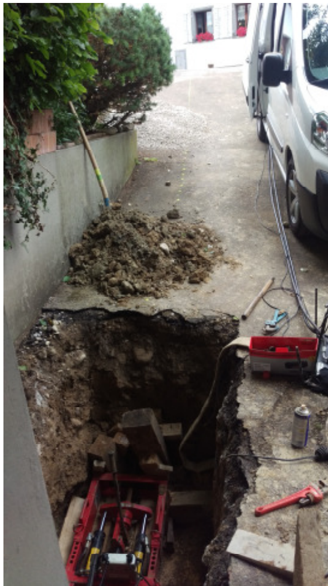
Bild 1: Die Startgrube wurde in der Hauszufahrt erstellt, anschliessend der TERRA-JACK verspannt und die Pilotpressung durchgeführt.
