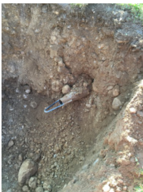
Bild 5: Die Aufweitungshülse erreicht die Zielgrube.
