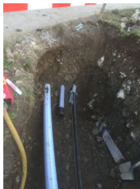
Bild 6: Bei dieser Querung wurden ein Rohr DA 112 mm sowie zwei Rohre DA 92 mm verlegt.
