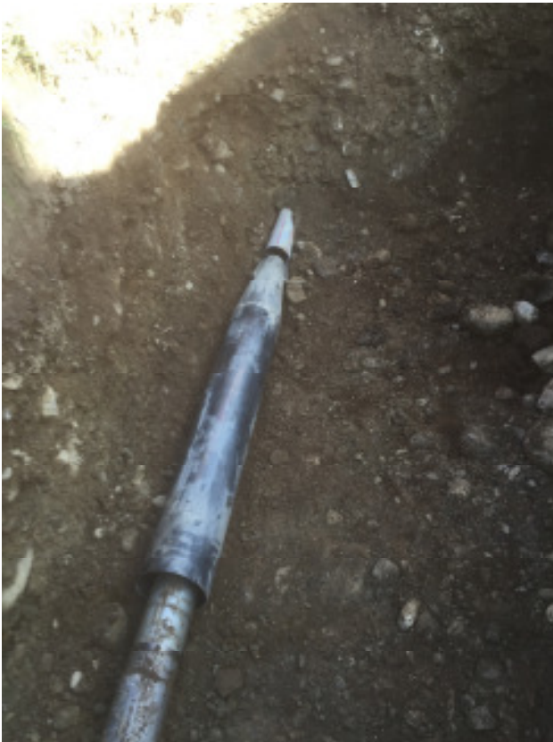
Bild 2: Der TERRA-HAMMER T 105 S wird in die Aufweitungshülse geschoben.
