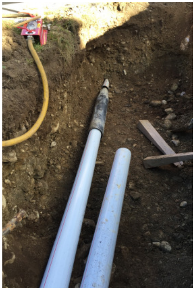
Bild 3: Das einzuziehende Kabelschutzrohr DA 112 mm wird in die Aufweitungshülse eingeschoben. Das in den Pilotkanal eingezogene Schutzrohr wird von der Aufweitungshülse herausgeschoben.
