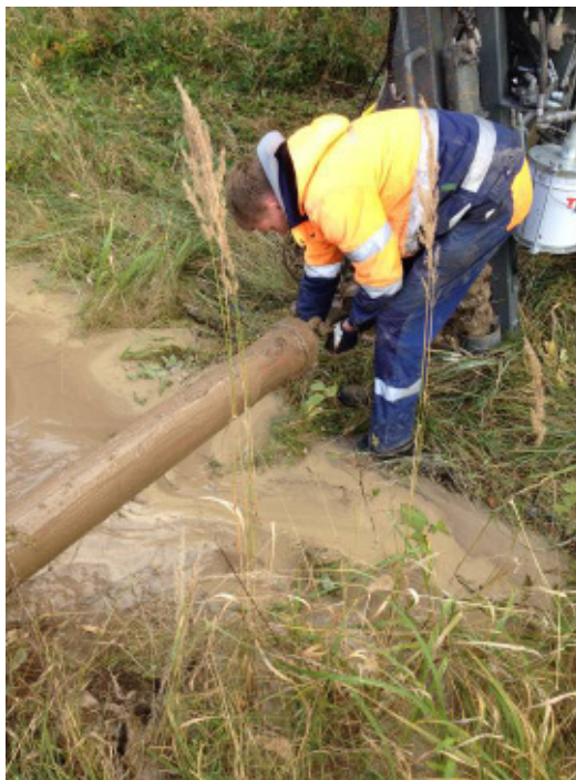
Bild 5: Insgesamt wurden bei diesem Projekt 5'800 Liter Bentonit benötigt. Eine Hochdruckpumpe mit 100 ltr/min Förderleistung ist beim TERRA-JET TJ 2808 S Standard.
