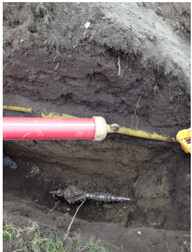
Bild 3+4: Nach erfolgreicher Pilotbohrung wurde ein Aufweitkopf DA 215 mm montiert, um das HDPE Kabelschutz- Rohr DN 160 mm einzuziehen. Nach nur 1 ½ Stunden war das Rohr über 65 Meter eingezogen.
