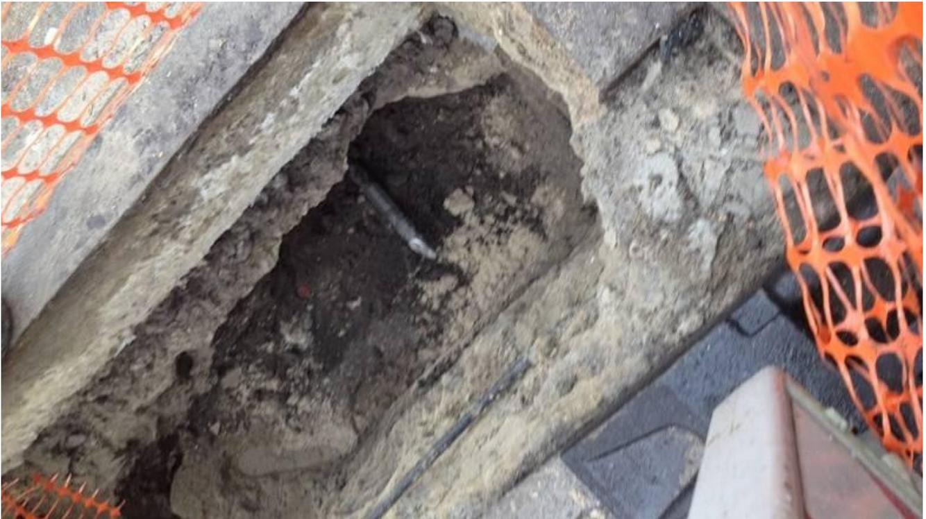
Bild 3: Auch beim Richtpressen ist zielgenaues Arbeiten möglich. Der Bohrkopf (Presskopf) erreicht zentimetergenau die Zielgrube.
