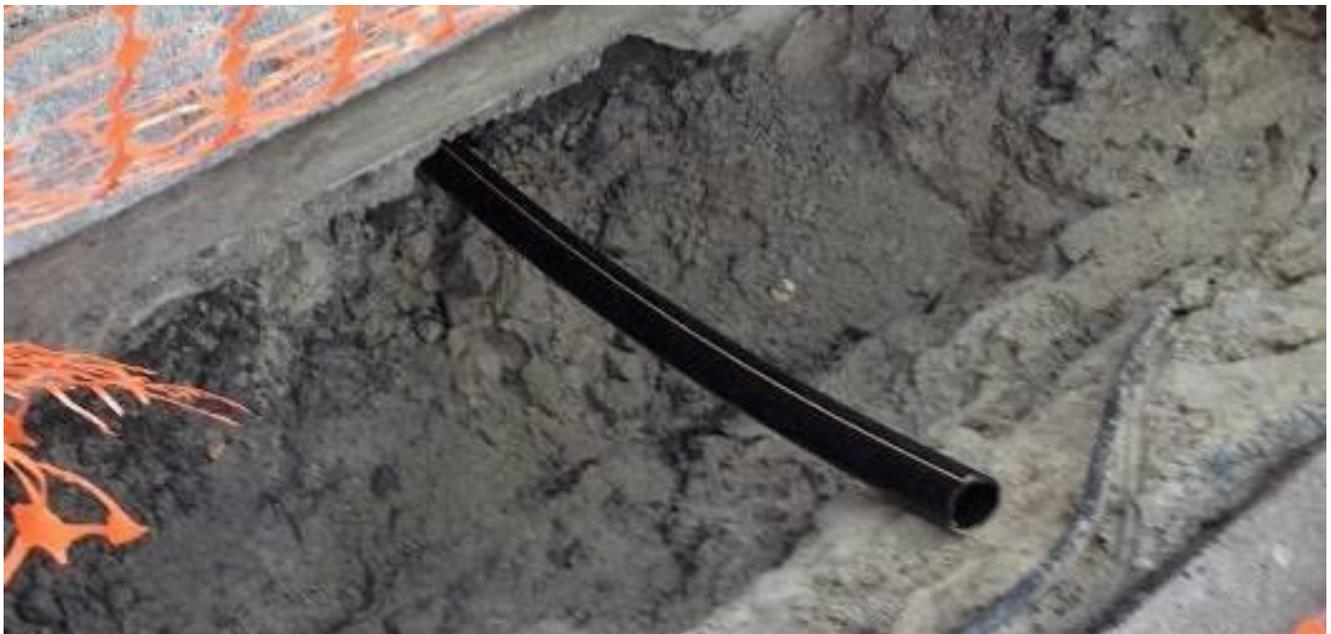
Bild 6: Das fertig ein gezogenes Schutzmantelrohr DA 50 mm.
