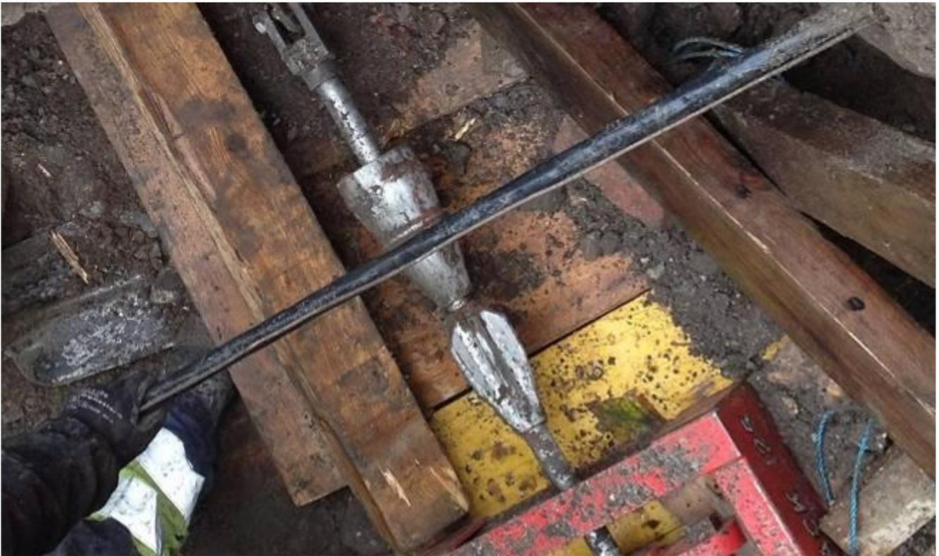
Bild 5: Die Ankunft vom Werkzeug mit dem eingezogenen Rohr. In nur 3 Stunden konnte die Baustelle mit 10 m Länge fertiggestellt werden.
