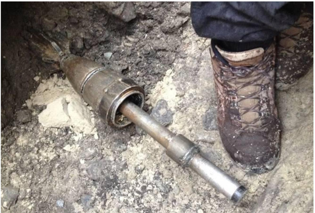
Bild 4: Nach erfolgter, zielgenauer Pilotpressung wird der Presskopf demontiert und anschliessend ein Aufweitstern sowie die Aufweitglocke montiert. Dahinter kommt das einzuziehende Produktrohr.
