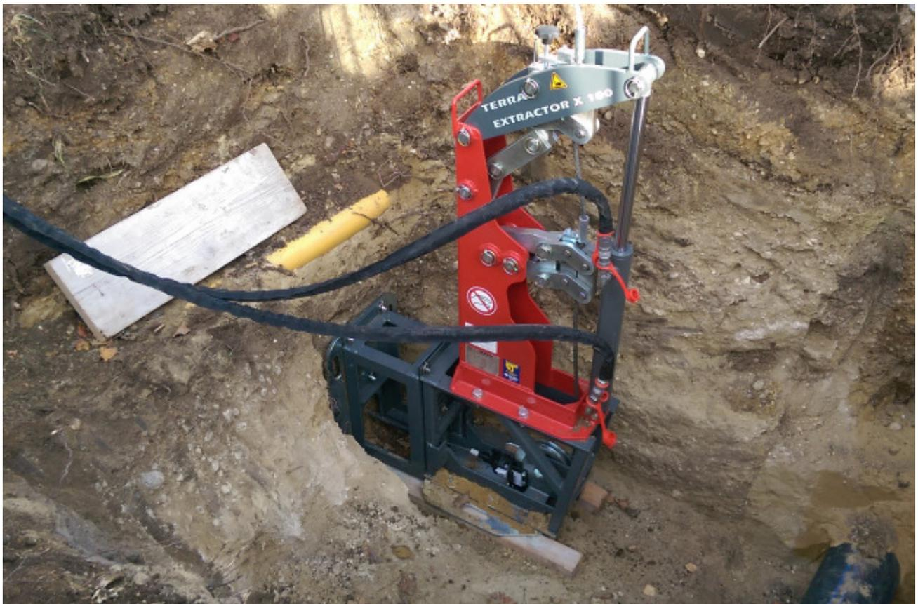
Bild 3: Auf der Zugseite bei der Hauptleitung wird das Seilende durch die Seilzugmaschine geschlauft und manuell durchgezogen. Die Berstlänge betrug hier 12 m und verlief unter dem Bürgersteig, der Hecke zum Grundstück sowie unter dem Garten vor dem Haus.
