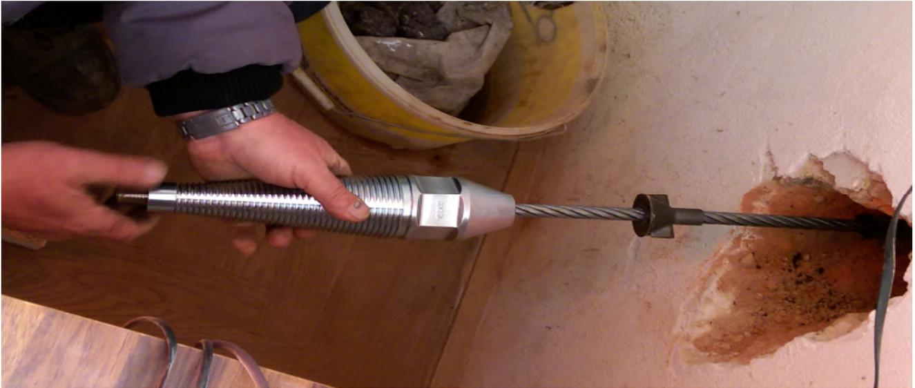
Bild 2: Im Keller wird die Altleitung von den weiteren Armaturen getrennt und rund um die Wanddurchführung freigespitzt. Anschliessend werden die Werkzeuganordnung und das einzuziehendes Neurohr an das Seil gekoppelt und zum Aufschnneiden und gleichzeitigen Rohreinzug bereitgelegt.
