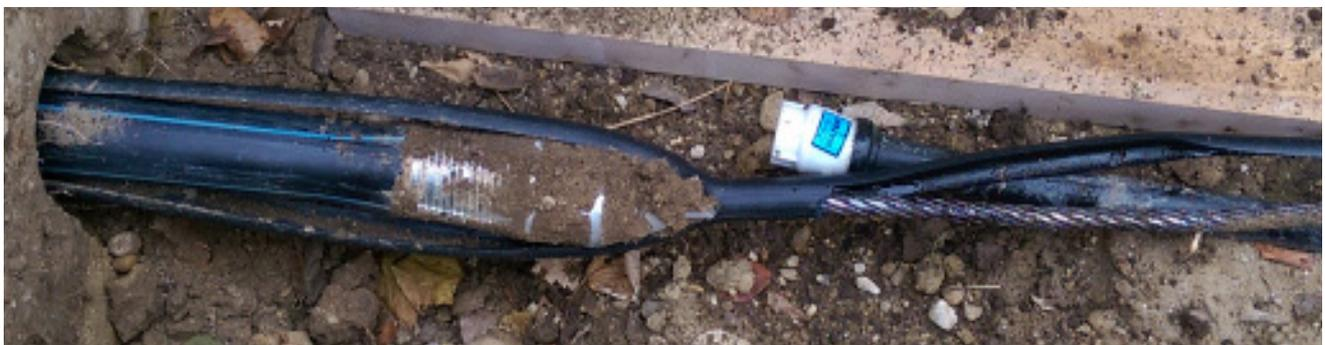
Bild 6: Das eingezogene PE-Rohr Aussendurchmesser 40 mm nach Deinstallation des TERRA-EXTRACTOR X 100. Die Hausanschlusserneuerung in Weiden verlief reibungslos. Die Firma Altenthaler Bau GmbH konnte mehrere Hausanschlüsse am Tag realisieren inklusive Anschluss an die unter Druck stehende Hauptleitung. Für die Hausbewohner bedeutete dies einen Verzicht auf Trinkwasserbezug von weniger als einem halben Tag.
