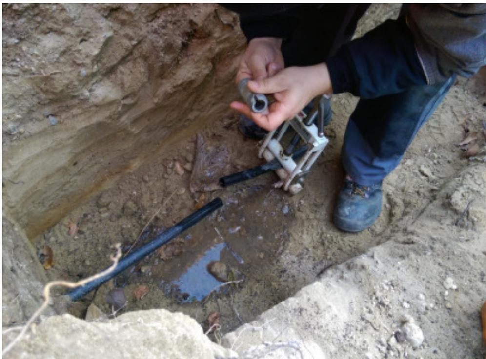
Bild 1: Grube mit minimaler Stellfläche von 0.65 x 0.40 m.
