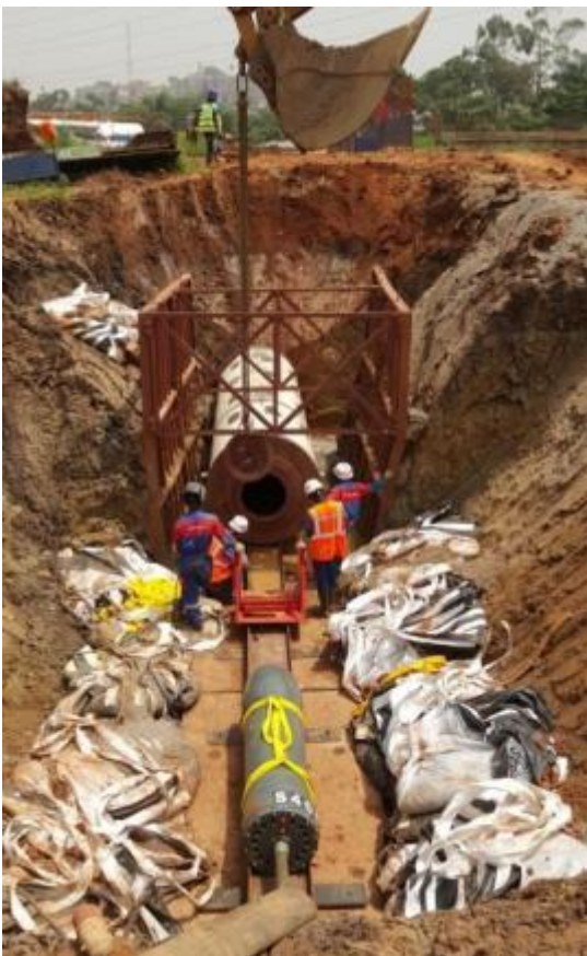
Bild 4: Die Rammringe und die TR 565 werden montiert.
