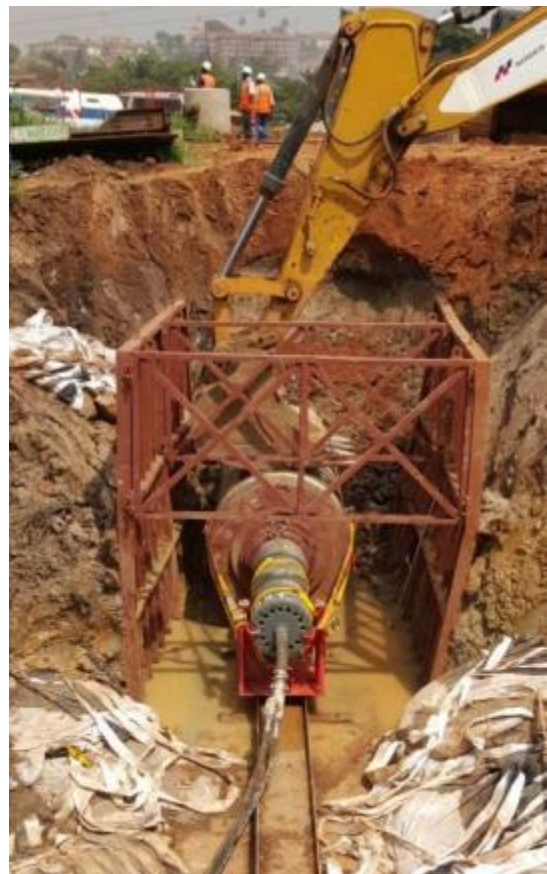
Bild 5: Befestigung und Verspannung der Stahlrohrramme mit den Rammringen. Die Schaufel des Baggers hält das Stahlrohr während der ersten Meter.
