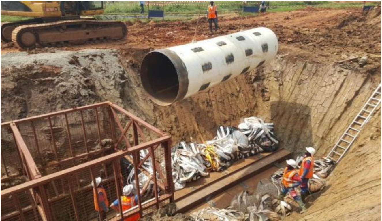
Bild 3: Das erste Stahlrohr \varnothing 1'500 mm wird in die Baugrube abgesenkt.
