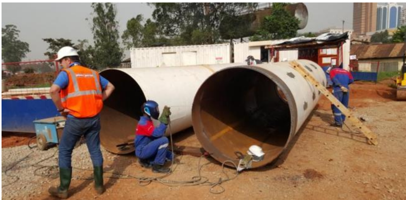
Bild 1: Vorbereitung des Schneidrings auf dem vordersten Stahlrohr. Dieser verstärkt „die Nase“ des Stahlrohres, um einer Deformierung im lehmig-sandigen Boden der Hauptstadt Kampala vorzubeugen.
