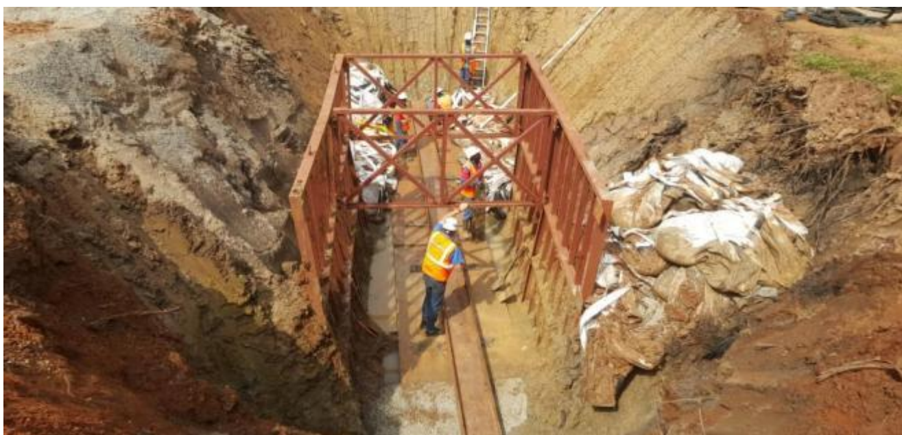
Bild 2: Text Baugrubenvorbereitung mit Erstellung eines Stahlträgers in entsprechendem Gefälle, welcher der Führung des Stahlrohres dient.
