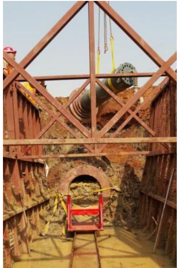
Bild 6: Ein 7m langes Stahlrohr wird mit einer Vorschubgeschwindigkeit von 11 m/h erfolgreich eingerammt. Die TR 565 wird demontiert.
