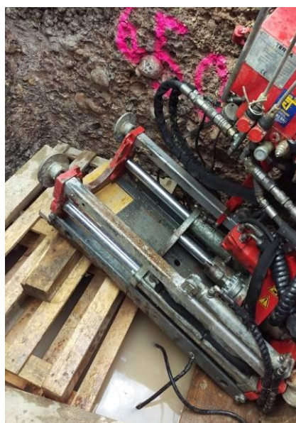
Bild 2: Einbau der Grubenlafette in die Startgrube
