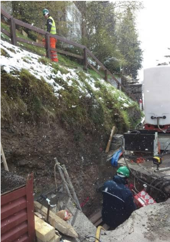
Bild 4: Sicht auf die Bohrtrasse
