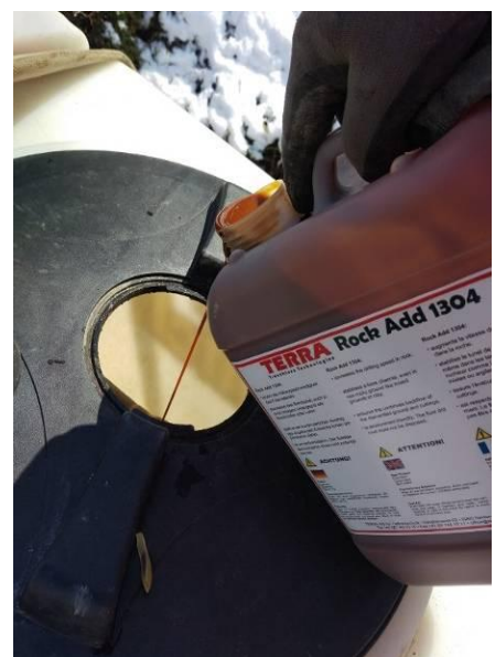
Bild 3: Beimischen des Spülungs-Zusatzes „Rock Add 1304“
