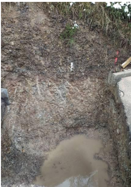
Bild 1: Aushub der Startgrube
